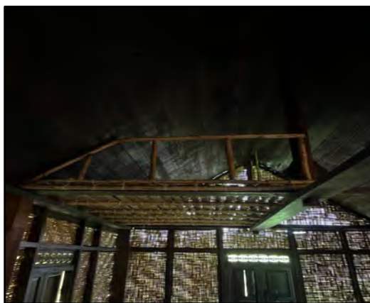
Figure 2: “Para Gantung” at Rumah Kutai, Kompleks Pasir Salak
