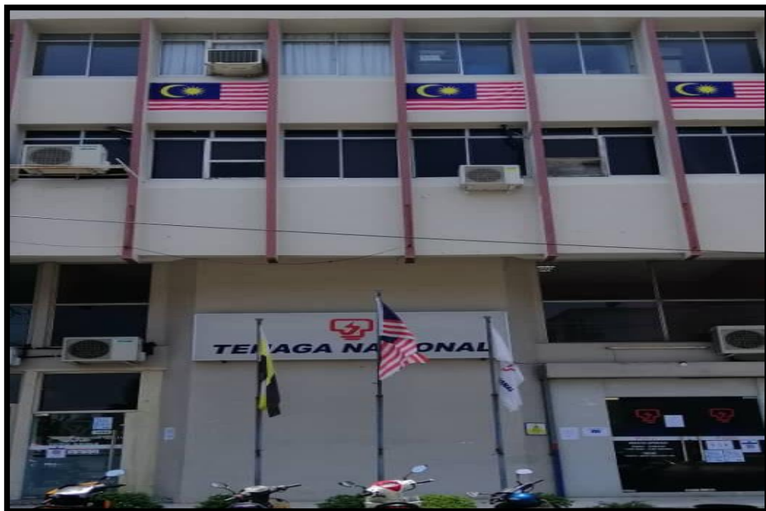
Figure 3: Tenaga Nasional Berhad Batu Gajah Perak
