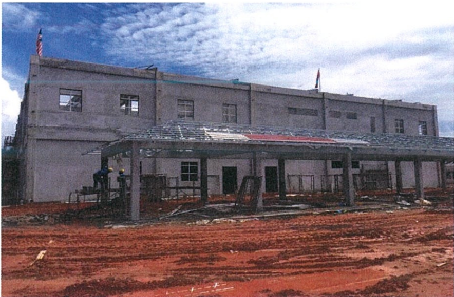
Figure 3.7 Main building of Pejabat Kesihatan Daerah Jeli, Kelantan
