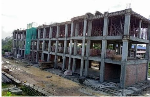
Figure 22: Project in progress of Sekolah Kebangsaan Kedaik, Rompin, Pahang.
