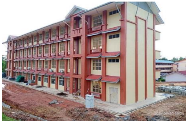
Figure 23: 87% completion of Sekolah Kebangsaan Kedaik, Rompin, Pahang.
