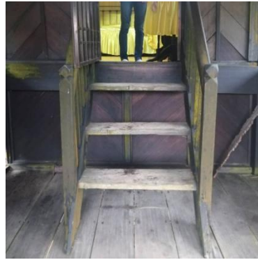
Gambar 17: Tangga yang menghubungkan beranda dan ruang tamu
