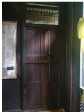
Gambar 19: Pintu belakang Rumah Lindungan Raja
