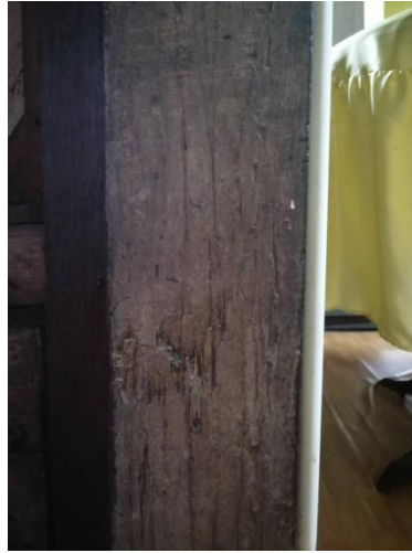
Gambar 20: Tiang asal yang dipotong menggunakan gergaji tangan
