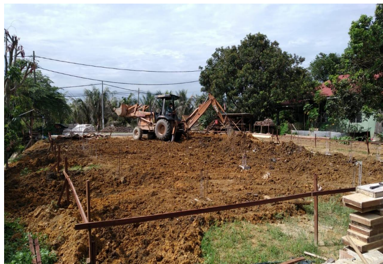
Figure 3.4.15 : Back filling
