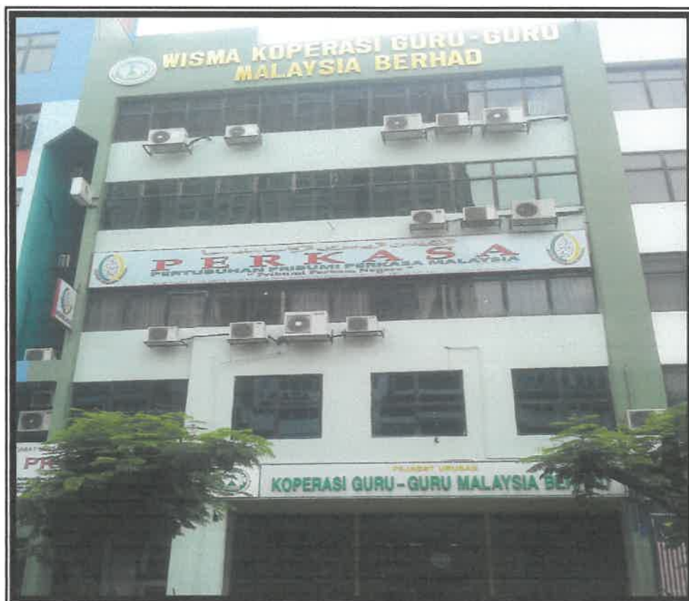
Gambar 24 : Gambar Bangunan Pejabat PERKASA di Tingkat 2.
