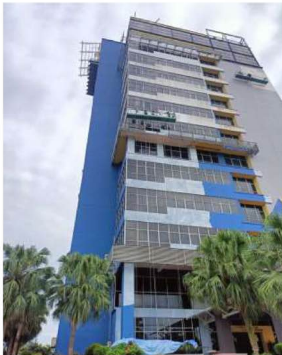
Photo 2.7 Side Elevation of Bangunan Menara Kastam Negeri Johor
