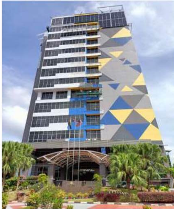
Photo 2.8 Front Elevation of Bangunan Menara Kastam Negeri Johor
