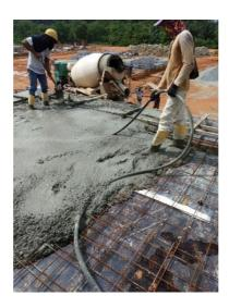
Figure 16 Concrete pouring
