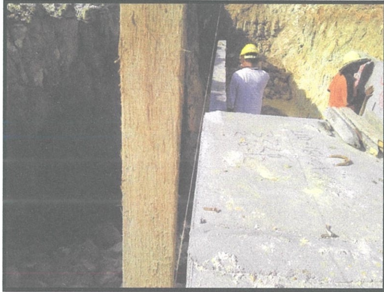
Gambar 3.9: Tali rujukan untuk kotak pembentung.
