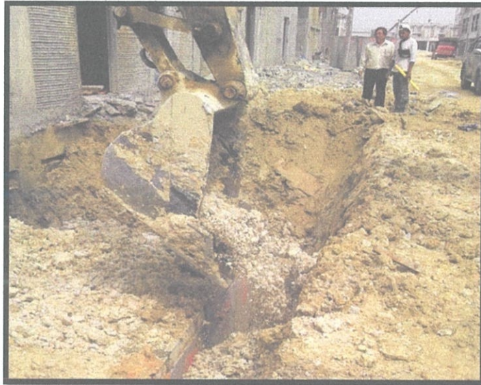
Gambar 3. 15: Kerja penimbunan tanah di sebelahkotak pembentung.
