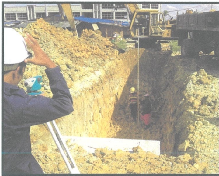
Gambar 3.6: Kerja ukur aras dilakukan.
