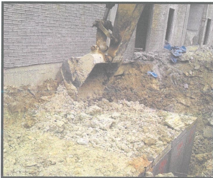
Gambar 3. 16: Kerja memadatkan tanah.
