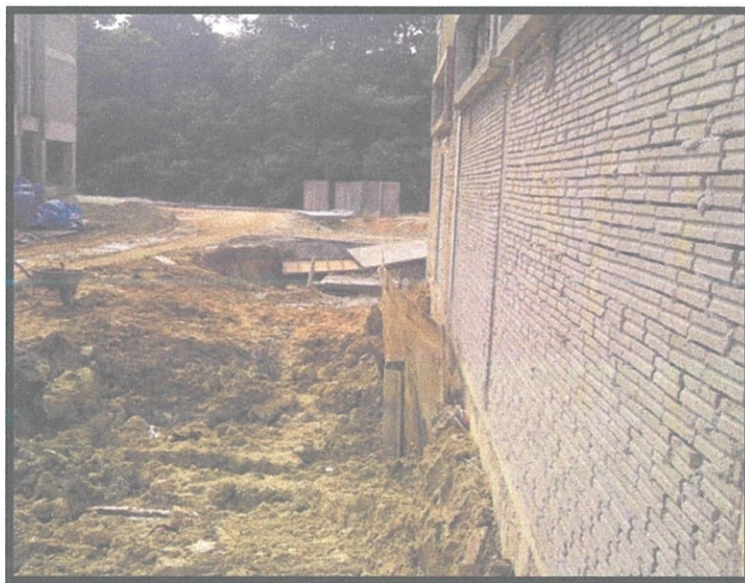
Gambar 3. 20: Plat keluli 4 m lebar dan 3m tinggi.
