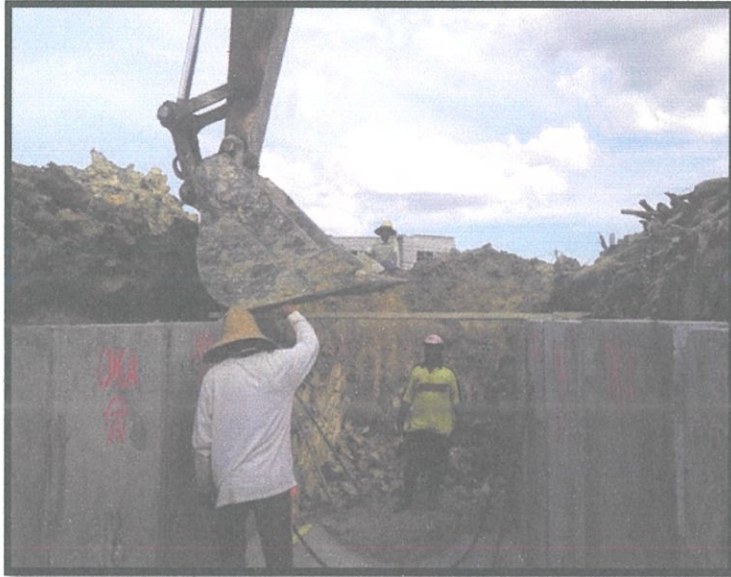
Gambar 3. 11: Kerja membetulkan kotak pembentung.
