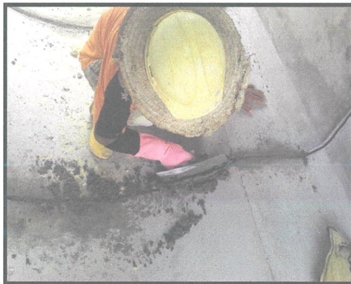
Gambar 3. 14: Mortar simen disapu menggunakan kulir.
