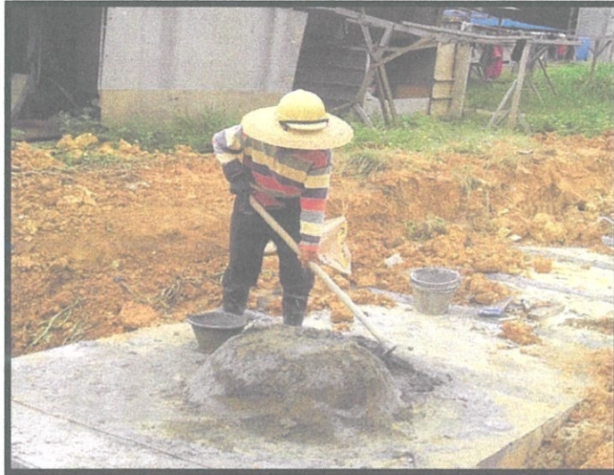
Gambar 3. 13: Pembancuhan mortar simen menggunakan cangkul.
