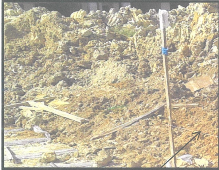
Gambar 3.2: Benang diikat pada kayu pancang yang ditanam.
