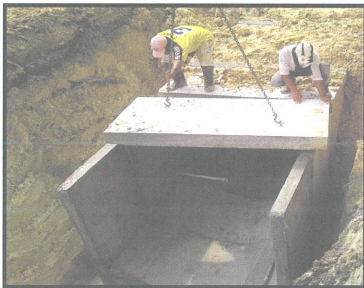
Gambar 3. 12: Kerja meletakkan penutup kotak pembentung.
