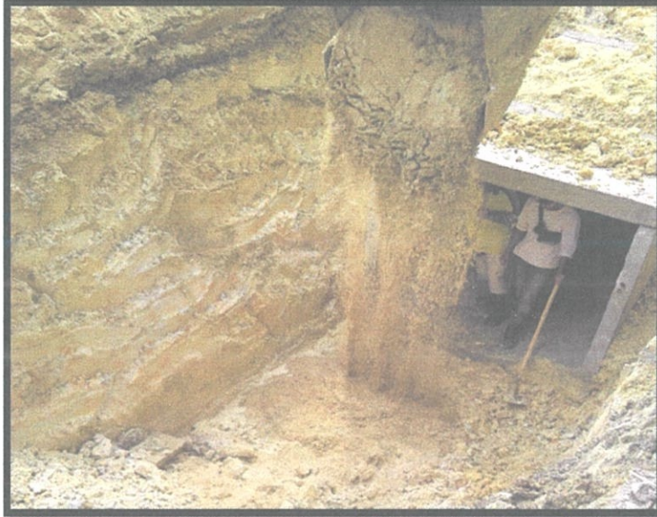
Gambar 3.7: Kerja meletakkan crusher run dilakukan oleh penggali.
