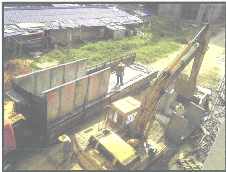
Gambar 3.1: Pemindahan kotak pembentung daripada sebuah treler.
