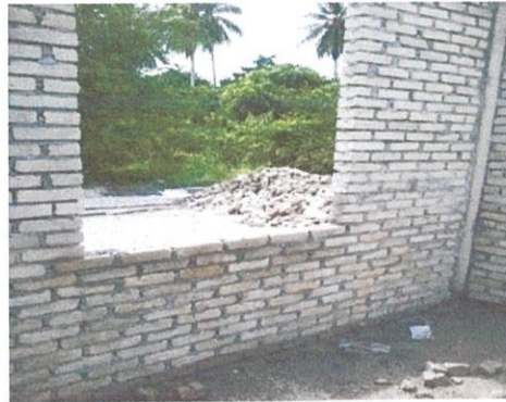
Gambar 3.8 : Ruang bukaan untuk tingkap
