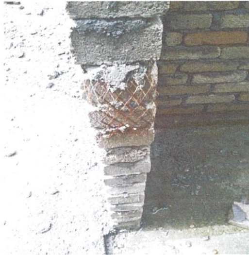
Gambar 3.4 : Pemasangan Jejaring Exmet
