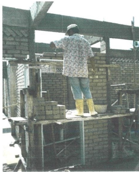
Gambar 3.15 : Ikatan bata pada kerangka pintu
