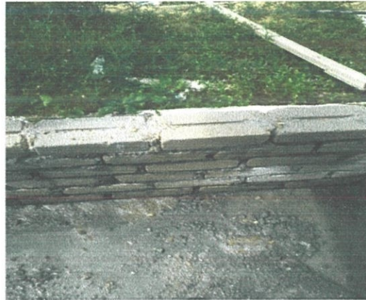
Gambar 3.7 : Susunan ikatan bata
