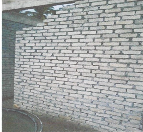
Gambar 3.10 : Ikatan dinding dalam
