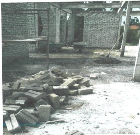
Gambar 3.5 : Bata dan mortar
