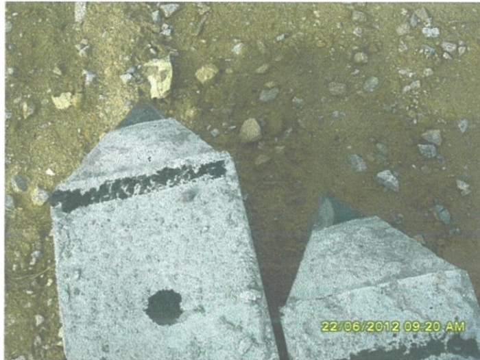
Gambar 3.3.1 Sepatu cerucuk jenis 'Pile Shoe'
