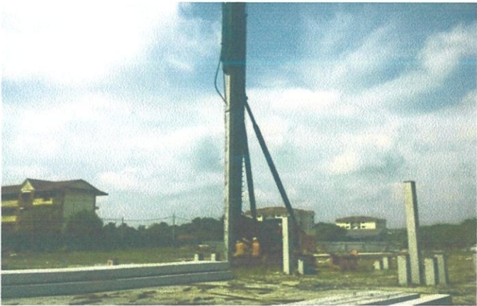
Gambar 3.3.1.2 Pekerja memastikan cerucuk berada di titik yang betul
