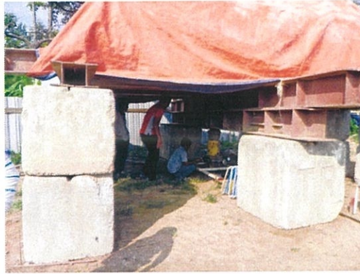
Gambar 3.3.2.1 Susunan 'Main Load Test'
