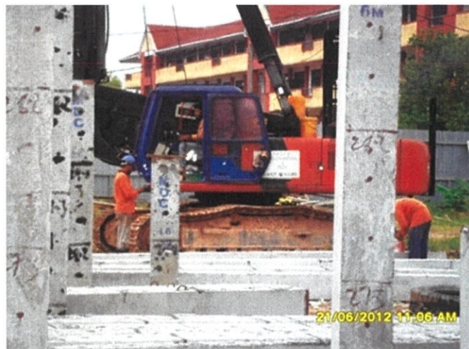
Gambar 3.3.1 Cerucuk konkrit bertetulang yang telah dilantak
