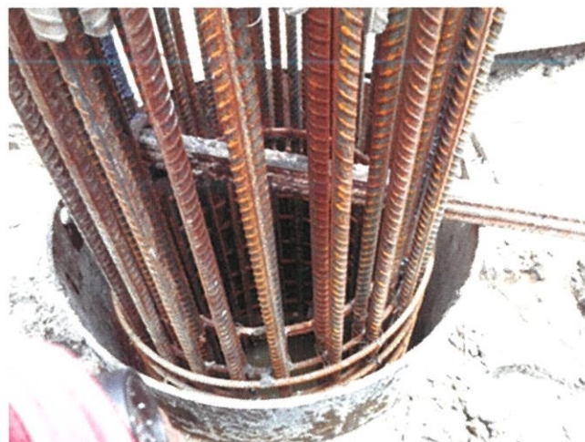
Gambar 3.1.5.6.3.1 'Steel Cage' yang telah ditanam bersama 'casing'
