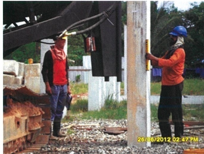
Gambar 3.3.1.3 Alat aras spirit digunakan untuk mendapatkan ketegakkan cerucuk
