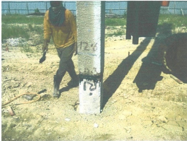
Gambar 3.3.1.4 Cat anti karat disapu setelah dikimpal
