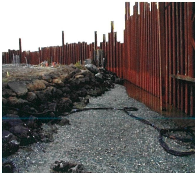
Gambar 3.1.5.6.2 'Sheet Pile'
