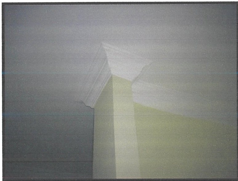
Gambar 4.1: Siling kapur pada rumah banglo 2 tingkat.
