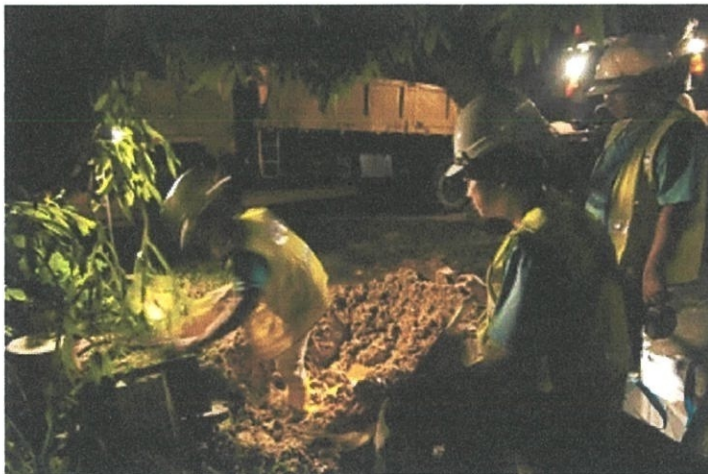
Gambarfoto 4.16 : Kerja memperbaiki paip pada waktu malam
