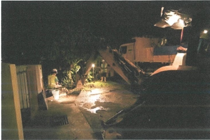
Gambarfoto 4.15 : Kerja memperbaiki paip pada waktu malam
