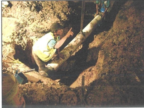
Gambarfoto 4.19 : Kerja-Kerja Ganti Paip
