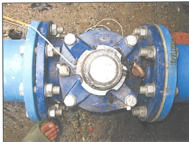
Gambarfoto 4.7 : Mekanikal Meter “Meinecke Meter”
