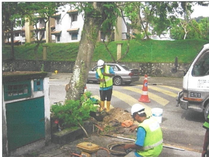
Gambarfoto 4.14 : Kontraktor membaiki paip bocor
