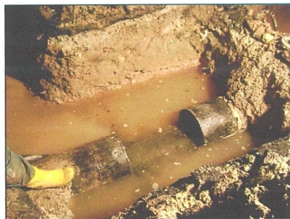
Gambarfoto 4.18 : Kerja-Kerja Ganti Paip
