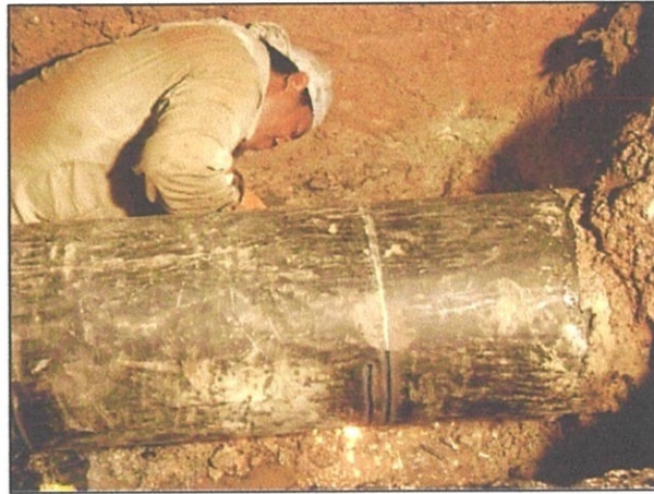
Gambarfoto 4.17 : Kerja-Kerja Ganti Paip
