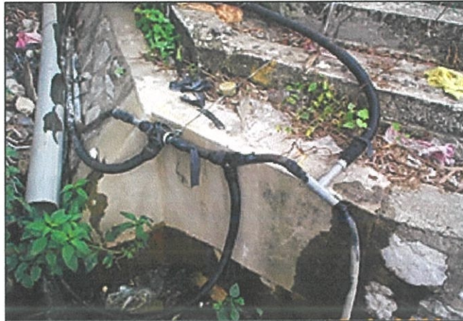
Gambarfoto 3.5 : Kerja-kerja pemasangan yang tidak berkualiti
