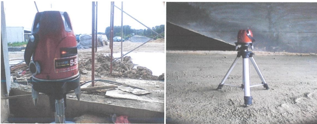
Gambarfoto 4.7: Mesin laser digunakan bagi memudahkan kerja melaraskan lantai.
