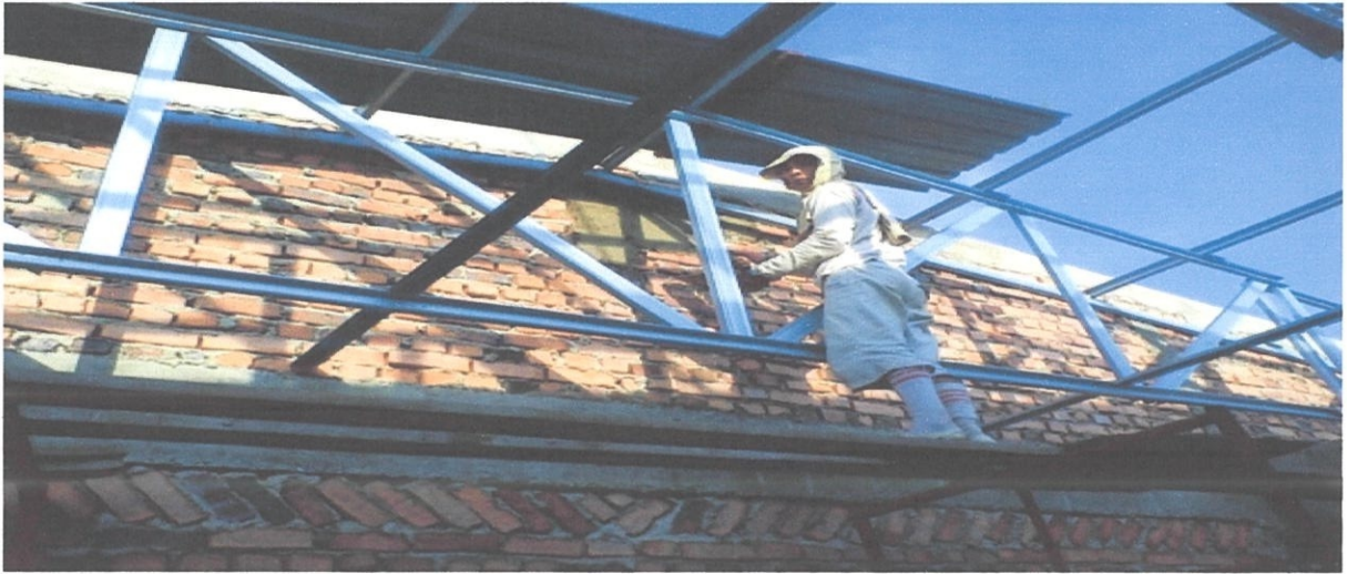
Gambarfoto 4.9: Kerja melepai tembok pembahagi terganggu dengan kekuda bumbung dan terdapat bahagian yang tidak dapat dilepa.
