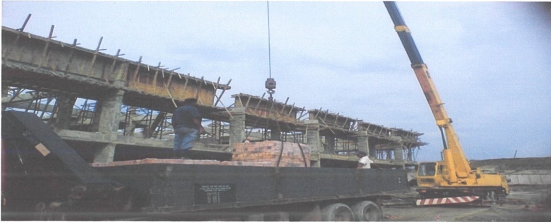
Gambarfoto 4.6: Jentera Kren digunakan untuk kerja permindahan batu bata ke atas bangunan.
