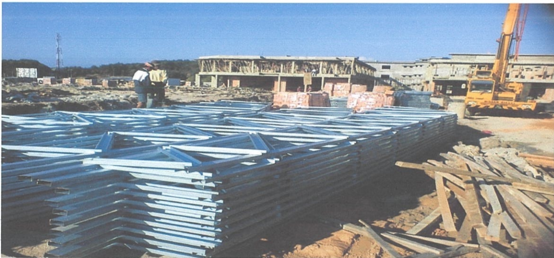
Gambarfoto 4.8: Jentera seperti kren perlu disewa ( kos langsung ) bagi kerja pemindahan struktur bumbung ke atas bangunan.
