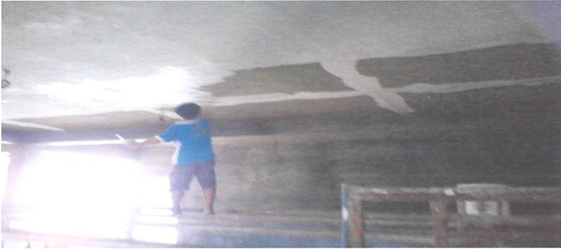
Gambarfoto 4.3: Kerja lapisan asas sedang dilakukan.
