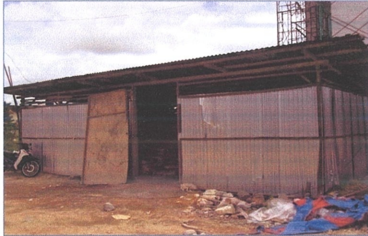
Gambarfoto 4.11: Stor tertutup untuk penyimpanan simen
