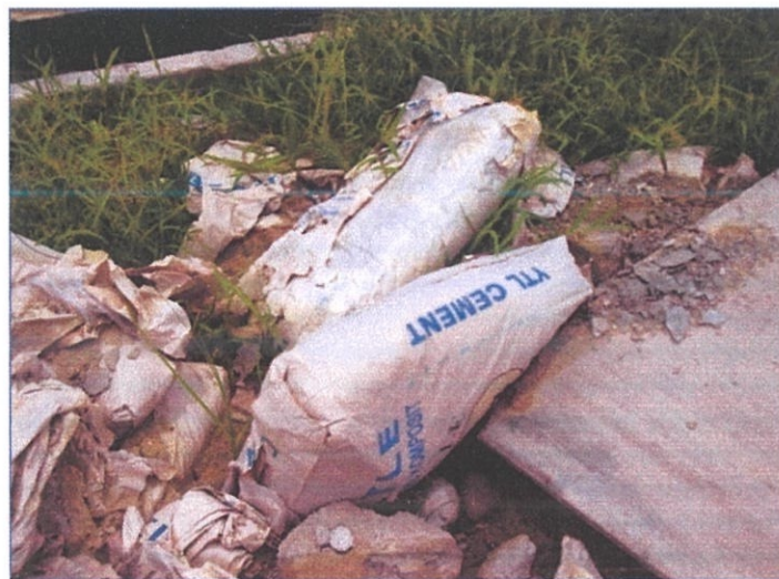
Gambarfoto 4.8: Pengerasan simen akibat terdedah kepada panas dan hujan
