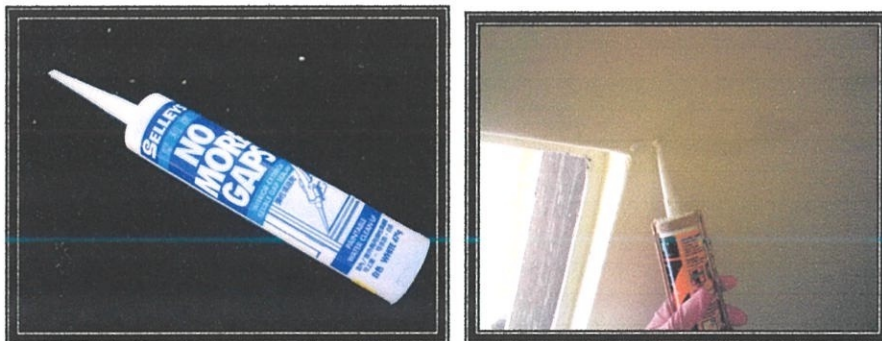
Gambar Rajah 5.3 : Alat yang digunakan untuk membaiki dinding
