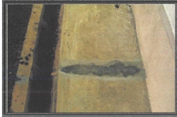
Gambar Rajah 3.8 : Lantai Yang Siap Ditampal
