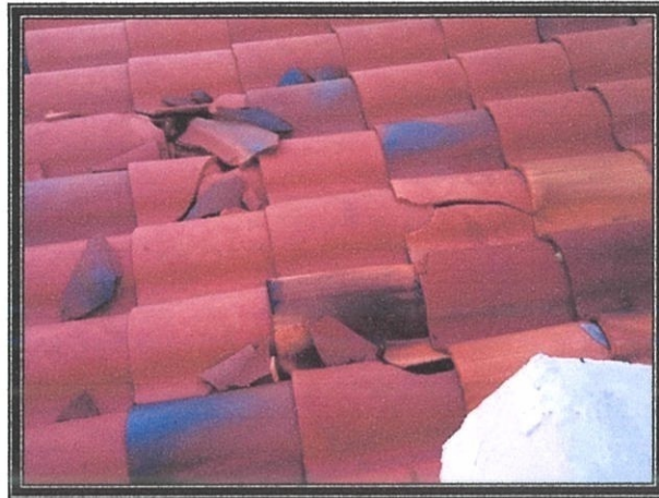
Gambar Rajah 3.4 : Atap Genting yang Telah Pecah
