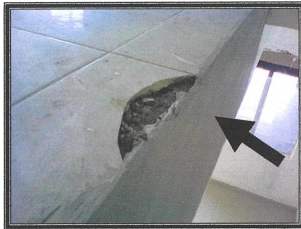
Gambar Foto 4.8 : Pecah pada mozek
