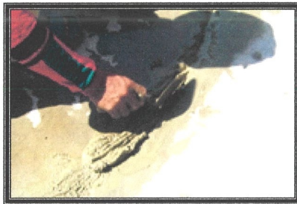
Gambar Rajah 3.7 : Kawasan yang diketuk akan ditampal
