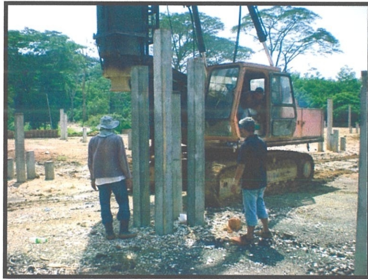
Gambar 3.18: Jentera cerucuk yang beroperasi di bahagian A
