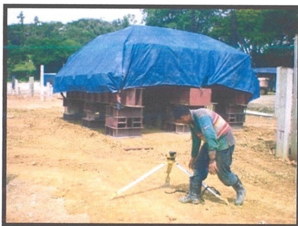
Gambar 3.20; pekerja sedang menjalankan kerja-kerja ujian beban.
