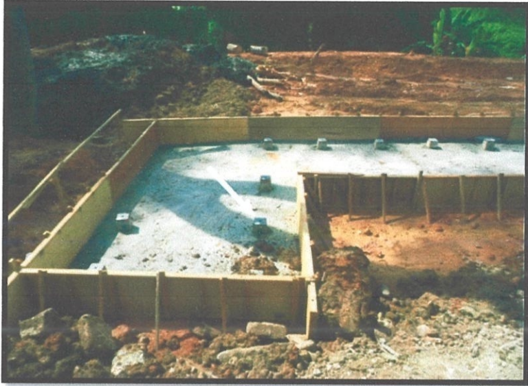
Gambar 3.3: Cerucuk bersaiz 150mm x 150mm untuk tembok penahan.
