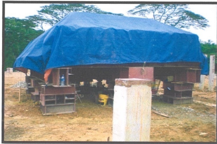
Gambar 3.14: Struktur ujian beban sedang dijalankan.
