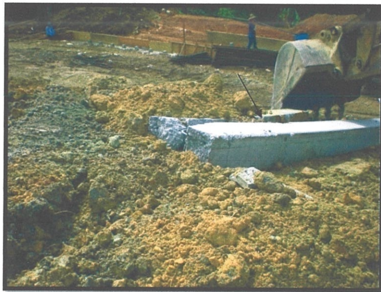
Gambar 3.13: Rekaan Cerucuk Yang Patah Sebelum Dipotong
