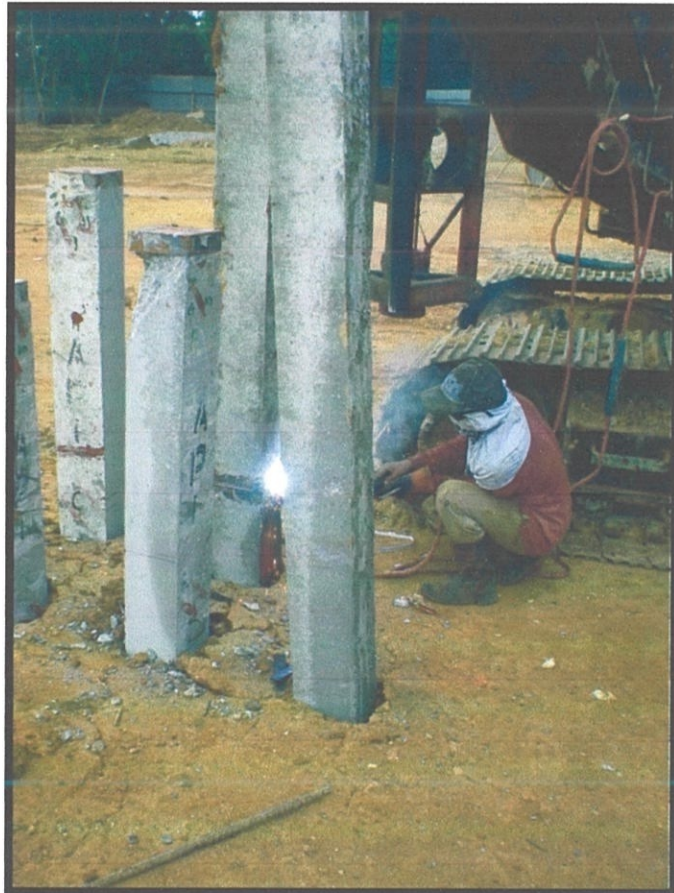
Gambar 3.8: Penyambungan Kaedah Kimpalan.
