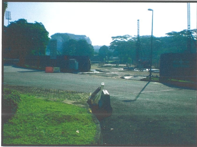
Gambar 3.1: Tapak pembinaan yang sedang dijalankan.
