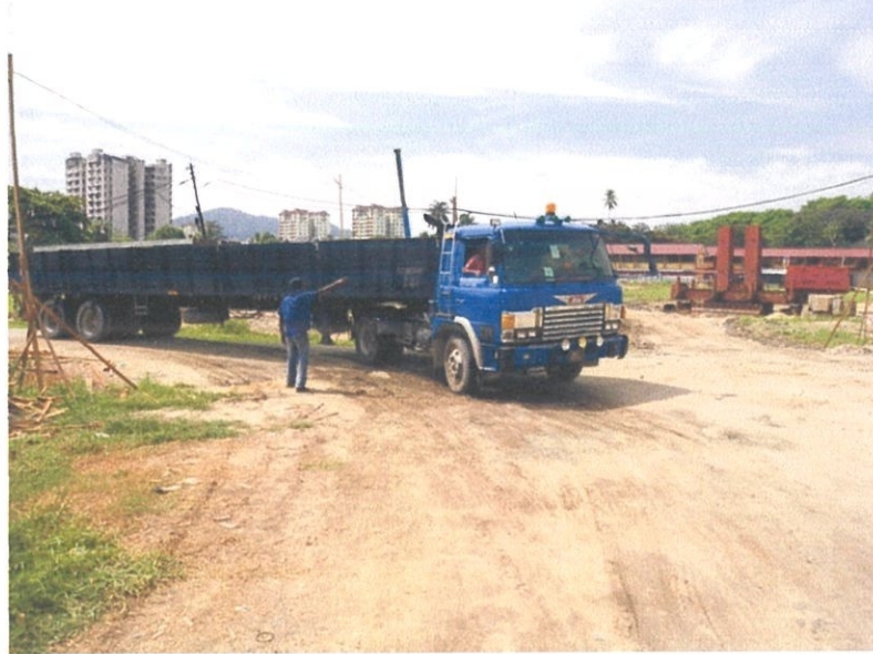
Gambar 3.5 : Kerja-kerja penghantaran cerucuk
