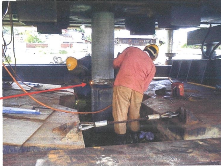
Gambar 3.13: Kerja-kerja meleburkan besi
