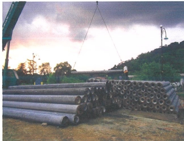
Gambar 3.6 : Kerja-kerja penyusunan cerucuk
