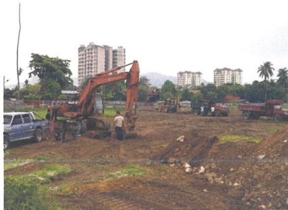
Gambar 3.4 : Kerja-kerja pembersihan tapak dijalankan
