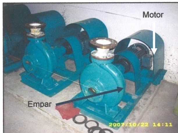
Gambarfoto 4.18 : Pemasangan pam empar
