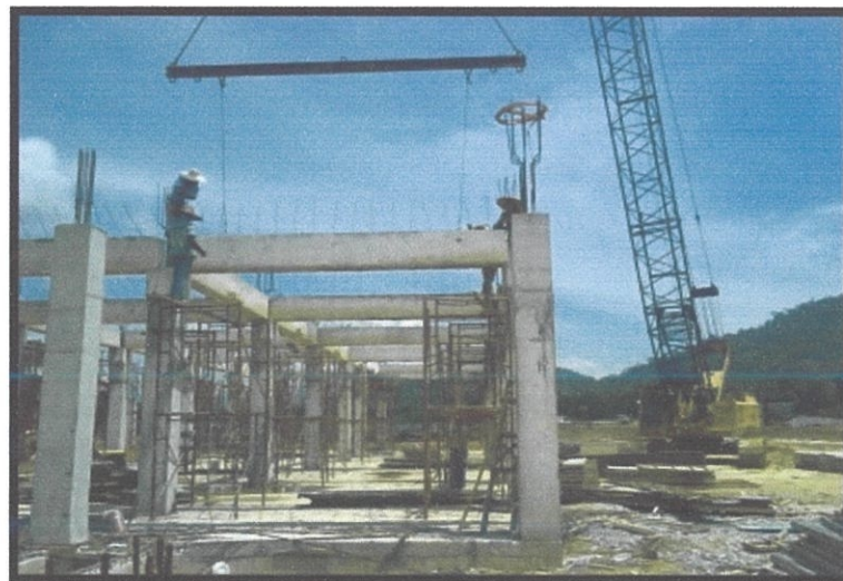
Gambarfoto 4.19: Kerja-kerja Pemasangan
