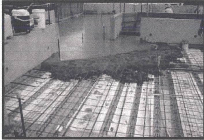
Gambarfoto 3.20: Penurapan Konkrit 'Concrete Topping'
