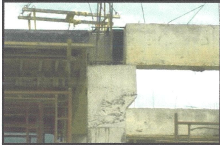
Gambarfoto 4.18: Kerja-kerja Pemasangan
