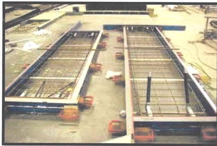
Gambarfoto 3.2: Kotak Acuan Lantai
