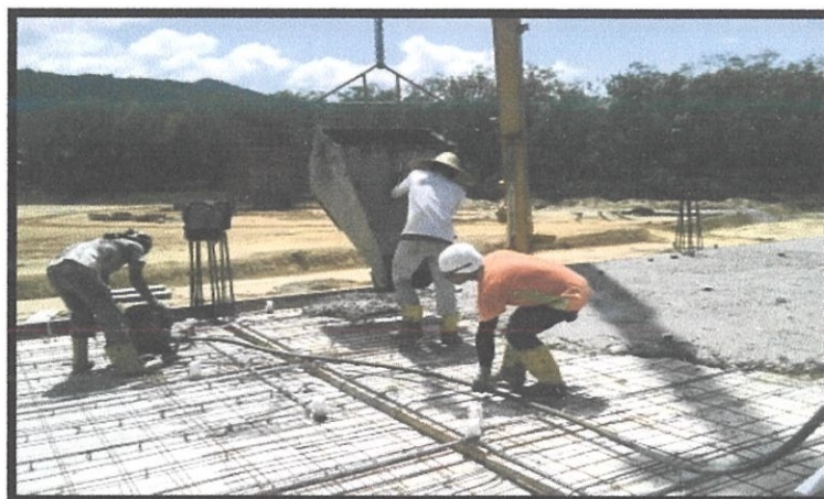
Gambarfoto 4.11: Penurapan Konkrit 'Concrete Topping'
