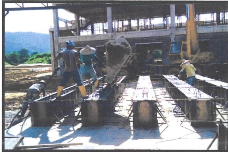
Gambarfoto 4.15: Kerja-kerja Konkrit Panel Rasuk
