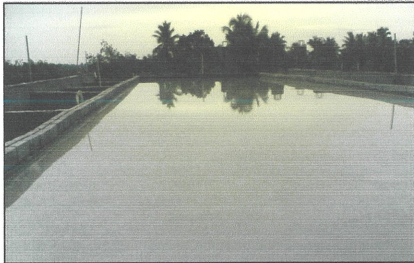
Gambarfoto 4.2 : Hasil Bahan Kalis Air Lantai Tangki Simpanan Air
