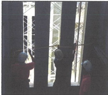
Foto 5.2 pengukuran melalui coping
