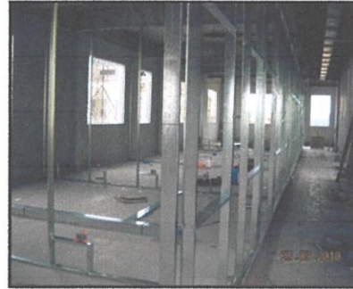
Foto 4.2 kerja pemasangan kerangka yang telah siap (30%).
