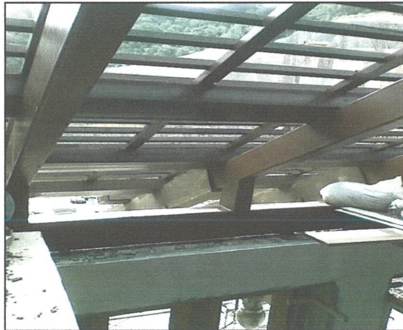
Gambarfoto 4.7 : Susunan struktur kasau yang dipasang
