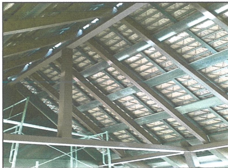
Gambarfoto 4.6 : Kedudukan struktur purlin
