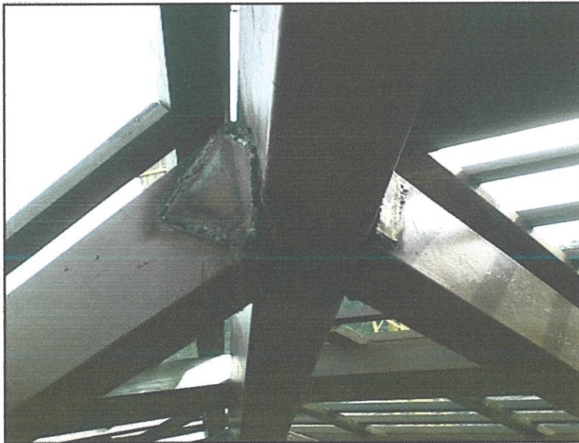
Gambarfoto 4.4 : Contoh sambungan secara kimpalan kekal
