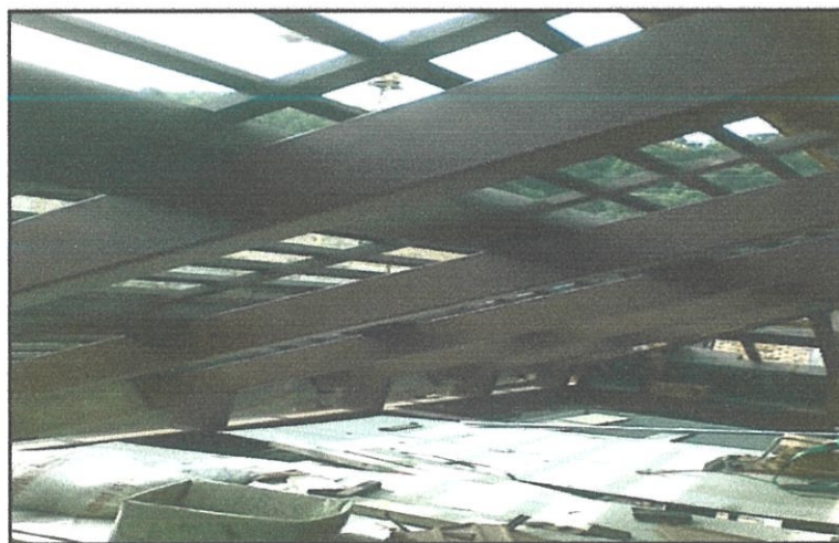
Gambarfoto 4.8 : Pemasangan beroti yang dilakukan di tapak bina
