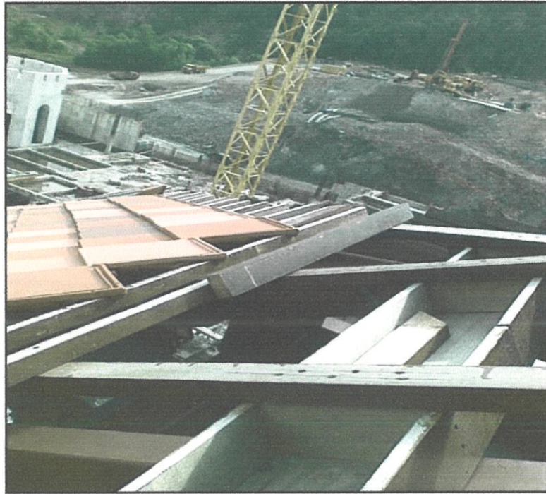
Gambarfoto 4.9 : Susunan kemasan bumbung di tapak bina
