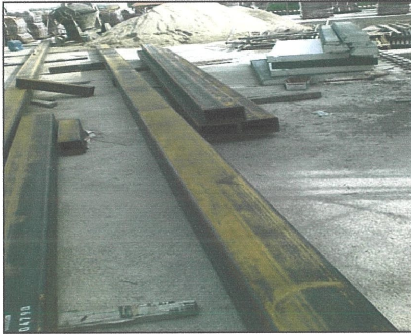
Gambarfoto 4.3 : Struktur besi keluli yang digunakan
