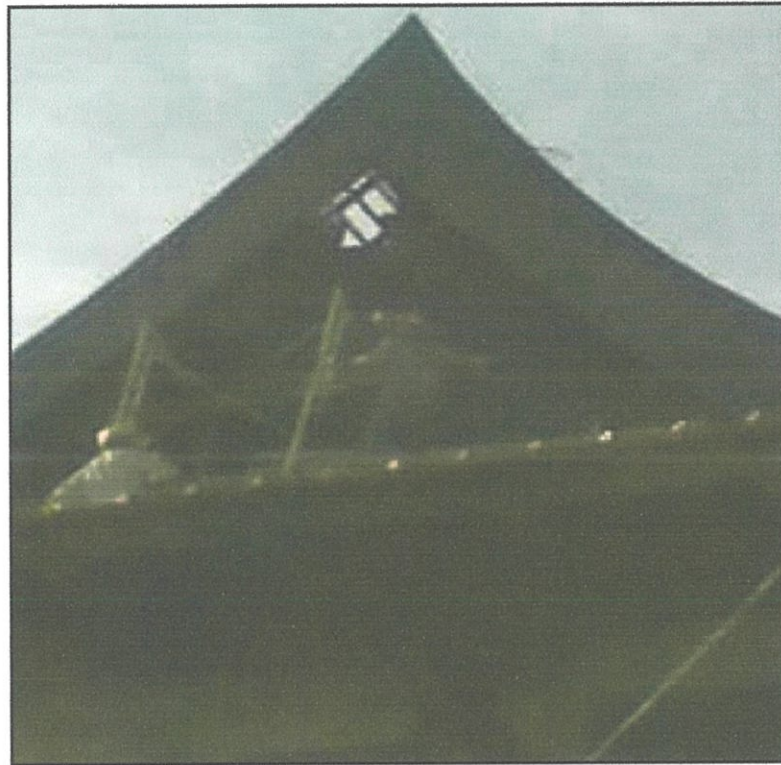
Gambarfoto 4.10 : Kerja-kerja pemasangan kerawang bumbung
