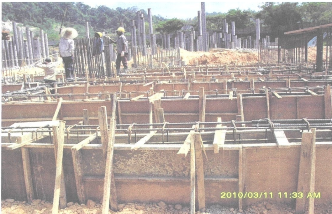
Gambar Foto 4.2 Pemasangan acuan kepada 'ground beam' Projek Kondominium Selayang
