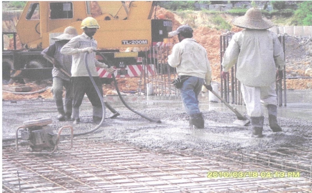
Gambar Foto 4.3 Kerja-kerja konkrit kepada 'ground slab' Projek Kondominium Selayang
