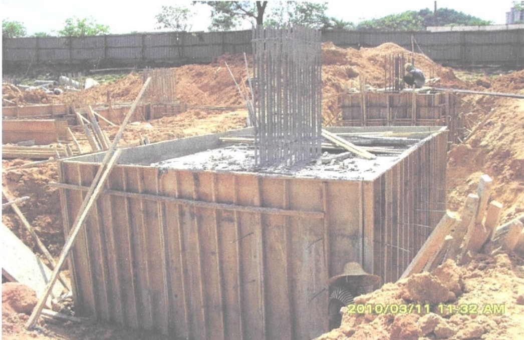
Gambar Foto 4.1 Kerja-kerja asas bagi Projek Kondominium Selayang.
