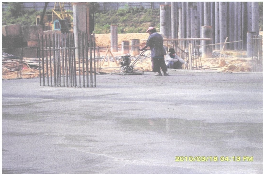
Gambar Foto 4.4 Kerja-kerja 'power float' bagi Projek Kondominium Selayang.
