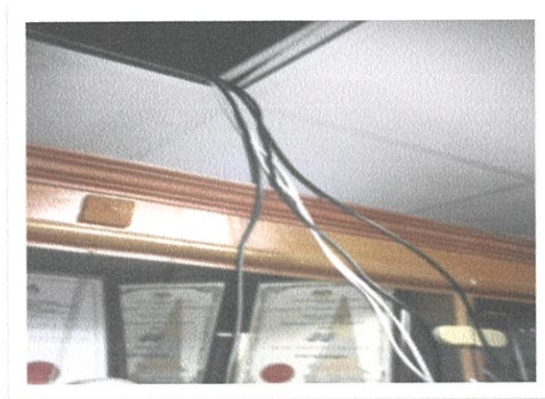
Rajah 3.6.1 (d) : Gambar menunjukkan titik mula menarik menarik kabel luar ke dalam.
