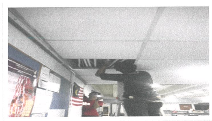
Rajah 3.6.1(e) : Gambar menunjukkan pekerja telah menarik kabel untuk disambung pada kamera CCTV.
