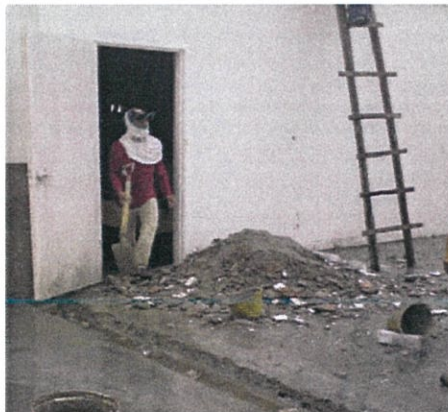
Gambar foto 3.1 : Kerja – kerja pembersihan membuang sisa konkrit yang musnah akibat hujan lebat.
