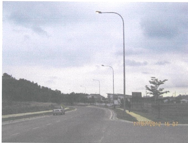
Gambar 2.8 Lampu-lampu jalan di sepanjang jalan ke arah SMK Forest Bayu.
