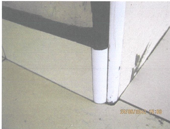
Gambar 3.6: Kerja-kerja membaiki jubin yang rosak/tertanggal.
