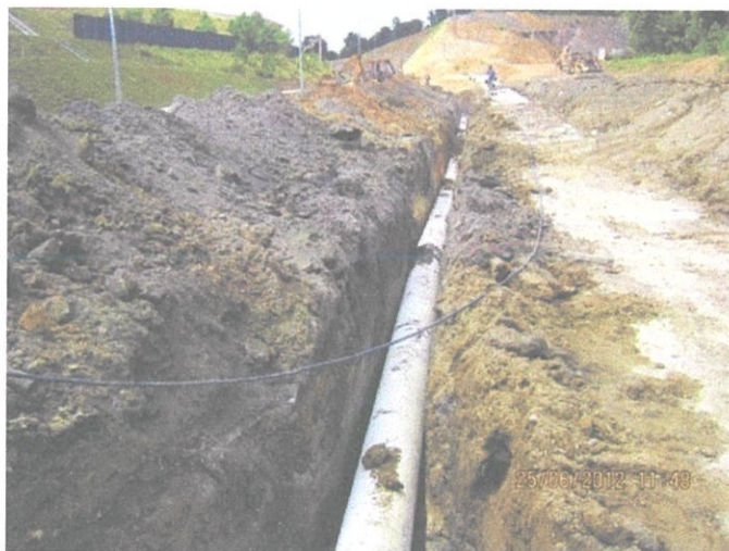
Gambar 2.7: Saliran Retikulasi Air di tapak bina SMK Forest Bayu, Seremban
