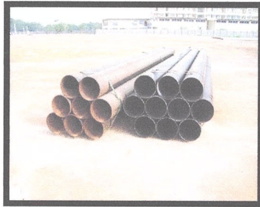
Gambarfoto 4.4: Sarung Besi Kekal dengan diameter 250mm dan 12m panjang
