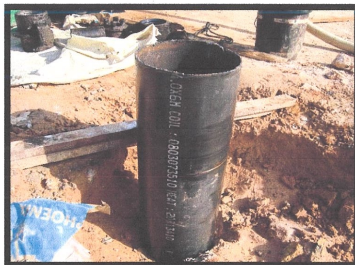
Gambarfoto 4.23: 'Casing' yang telah siap di tanam
