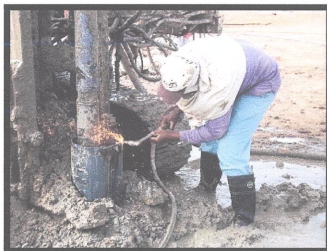
Gambarfoto 4.19: Penyambungan pada 'casing'
