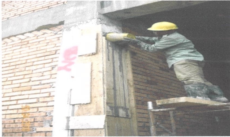
Gambarfoto 4.23: Bancuhan Simen Epoksi Dituang Ke Dalam Kekotak Acuan
