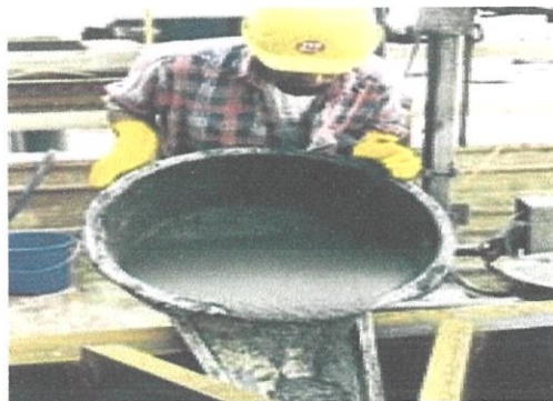
Gambarfoto 3.15: Penuangan Sikacrete-08 SCC dengan berhati-hati
