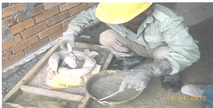
Gambarfoto 4.22: Sika Grout-215 Dibancuh Dengan Air Pada Kadar Ditetapkan
