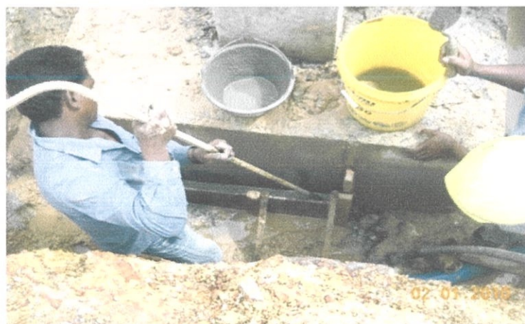
Gambarfoto 4.17: Simen Epoksi Dipadatkan
