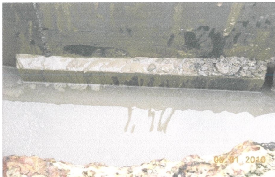
Gambarfoto 4.19: Keadaan Simen Epoksi Apabila Kekotak Acuan Dibuka
