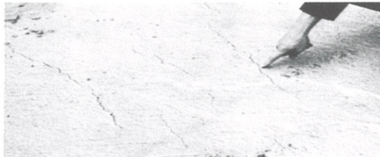
Gambarfoto 3.4 : Keretakan Pengecutan Plastik pada Lantai Konkrit
