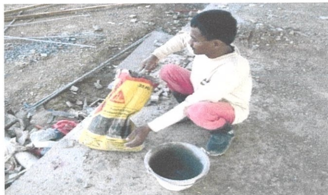
Gambarfoto 4.10: Pekerja Membancuh Simen Epoksi
