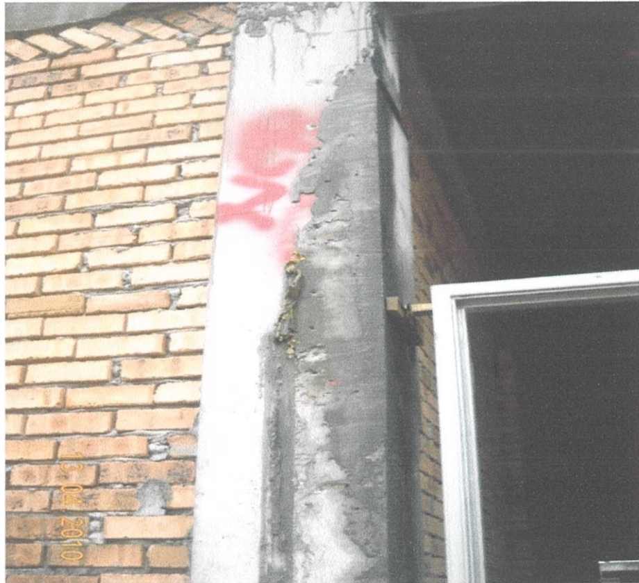
Gambarfoto 4.25: Struktur Konkrit Yang Siap Dibaiki
