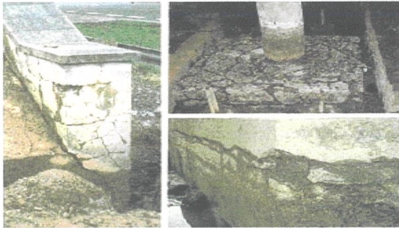
Gambarfoto 3.7: Tindak Balas Silika-Alkali Yang Kritikal Pada Struktur Konkrit
