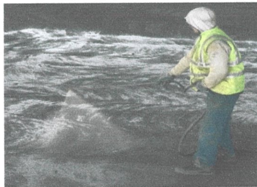
Gambarfoto 3.19: Kerja-Kerja Penyemburan Sebatian Pengawet
