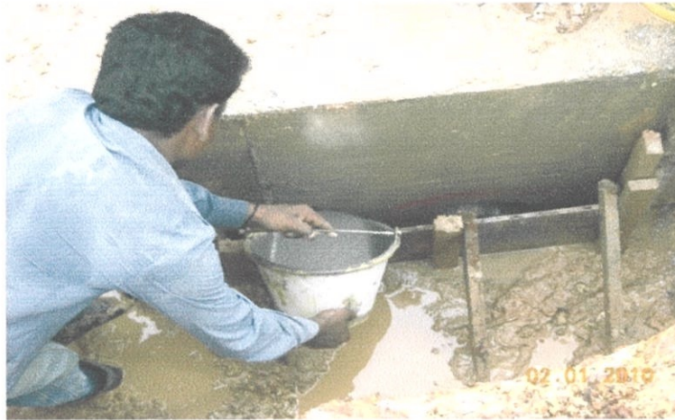
Gambarfoto 4.16: Simen Epoksi Dituang Ke Dalam Kekotak Acuan
