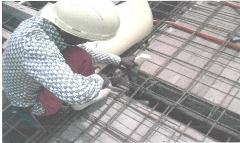
Gambarfoto 4.3: Span disumbat pada lubang yang terdapat pada kekotak acuan
