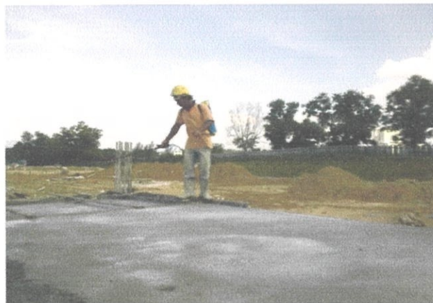
Gambarfoto 4.7: Semburan Sebatian Pengawet Pada Konkrit Yang Masih Basah
