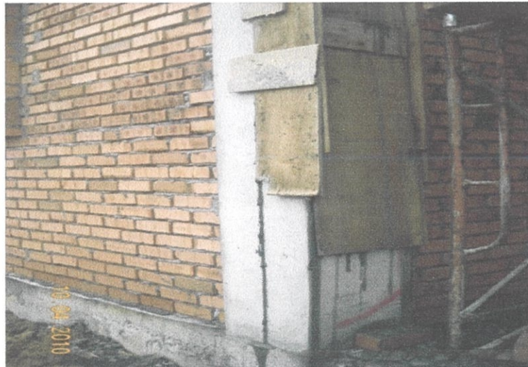
Gambarfoto 4.24: Simen Epoksi Mengalir Keluar Dari Bawah Kekotak Acuan
