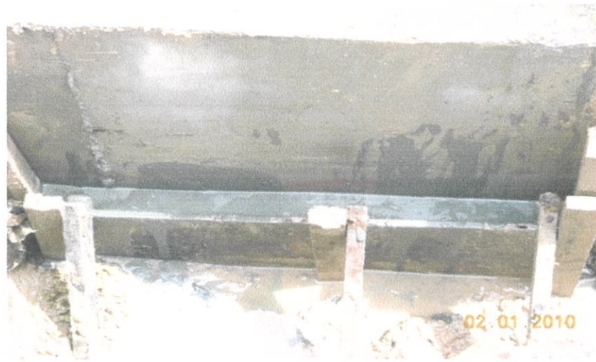
Gambarfoto 4.18: Simen Epoksi Dibiarkan Mengeras Selama 24 Jam
