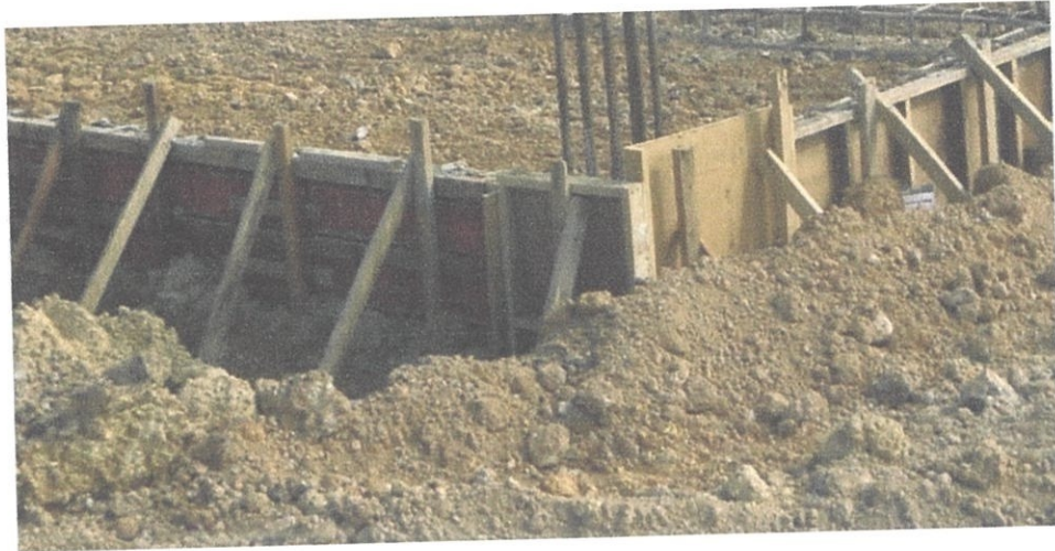
Gambarfoto 3.10: Kayu tupang 1x2 inci digunakan sebagai penyokong bagi kekotak acuan bagi rasuk
