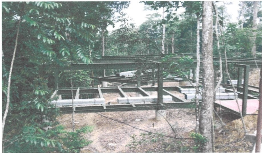
Gambarfoto 5.4: Pembinaan Dengan Struktur Keluli
