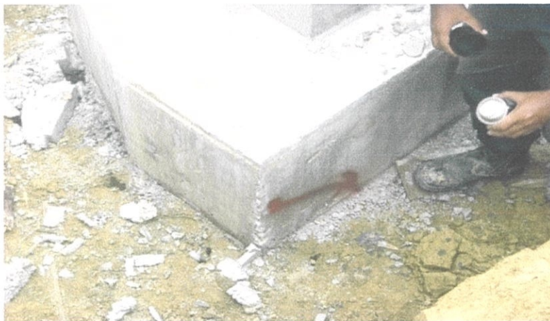
Gambarfoto 4.5: Kecacatan Pada Asas Konkrit Ditanda Cat Merah
