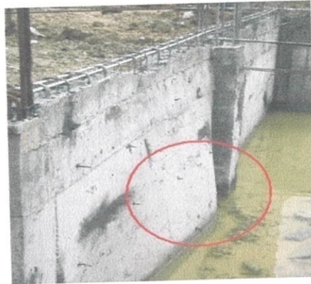
Gambarfoto 3.9 : Bulatan Menunjukkan Pengembangan Pada Struktur Rasuk Konkrit
