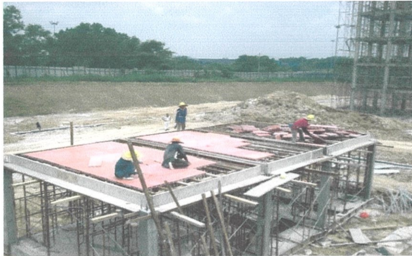
Gambarfoto 5.3: Kerja Pemasangan Kekotak Acuan Plastik Pada Struktur Lantai
