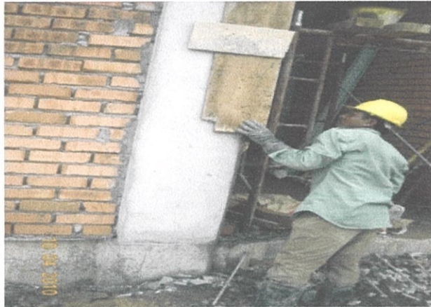
Gambarfoto 4.21: Pemasangan Kekotak Acuan Pada Tiang Yang Siap Dipahat
