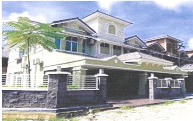
Photo 2.9: Taman Ilmu Indah , Nibong Tebal ( phase 1 )
