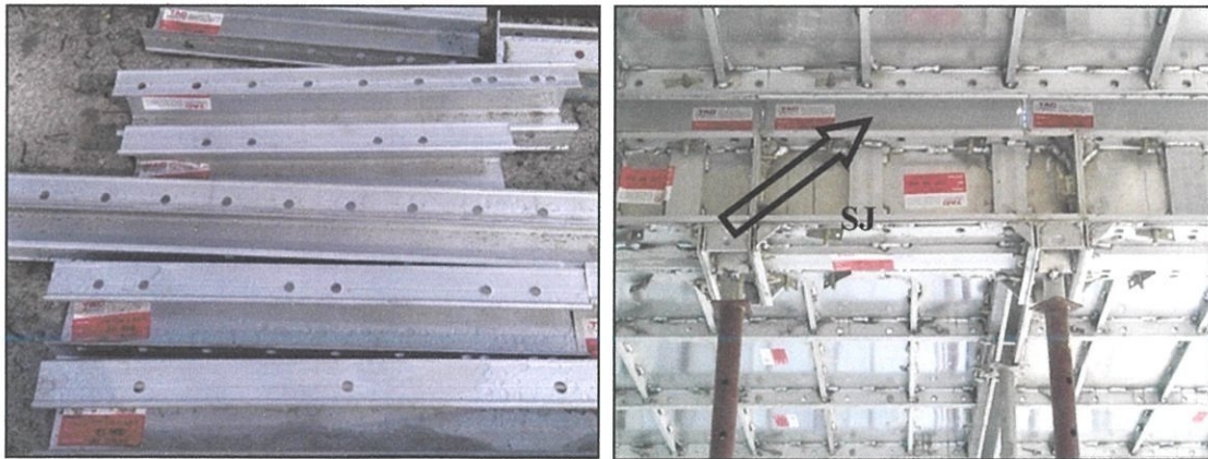
Photo 3.19: Slab Joint (SJ)
