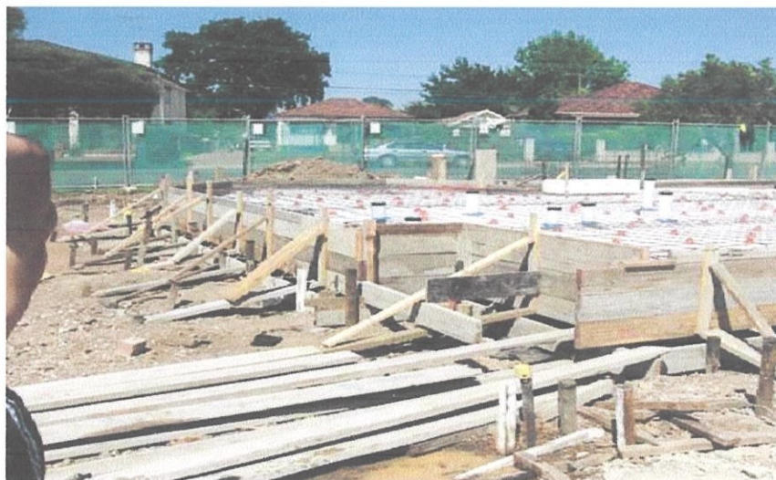
GAMBARFOTO 3.0: Acuan konkrit kayu (lantai)
