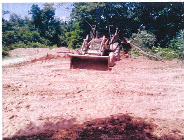
Gambar foto 3.1 Kerja pembersihan tapak
