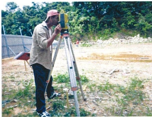
Gambar foto 3.5 mengambil bacaan kedudukan asas
