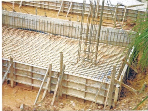
Gambar foto 3.34 Pemasangan column stump
