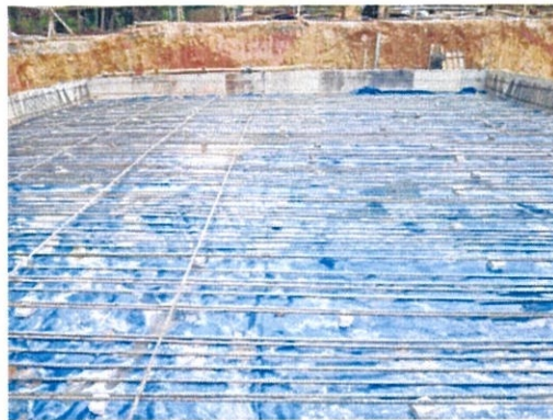
Gambar foto 3.14 susunan spacer block
