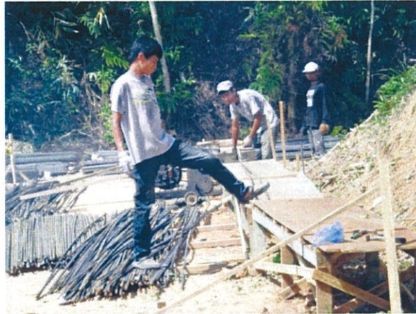
Gambar foto 3.12 Pemotongan besi tetulang
