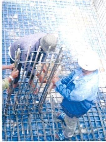
Gambar foto 3.18 Pemasangan tiang pancang
