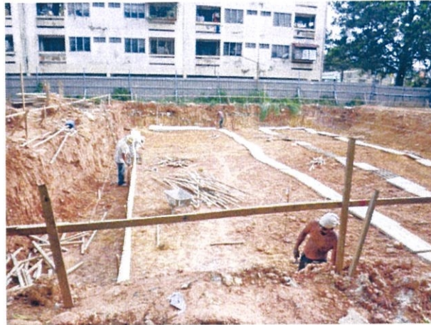
Gambar foto 3.31 Membuat kotak acuan asas jalur
