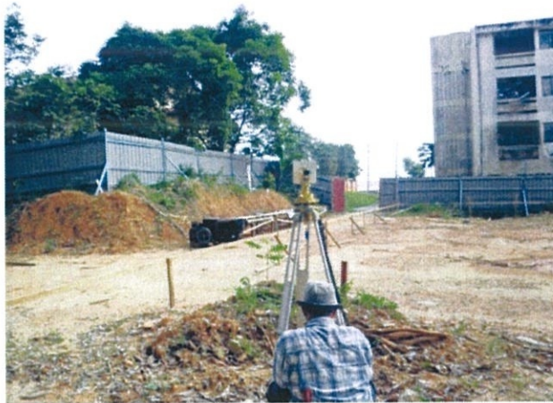
Gambar foto 3.4 Kerja mencari sempadan bangunan
