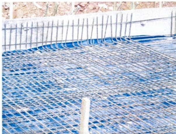
Gambar foto 3.17 Susunan besi tetulang 100 c/c
