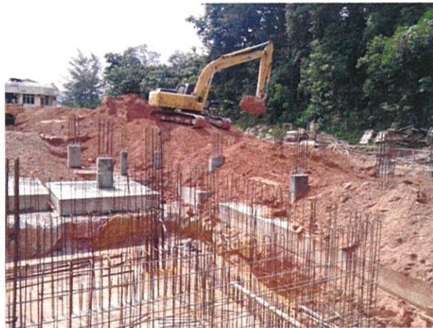
Gambar foto 3.28 Kerja pengambusan asas
