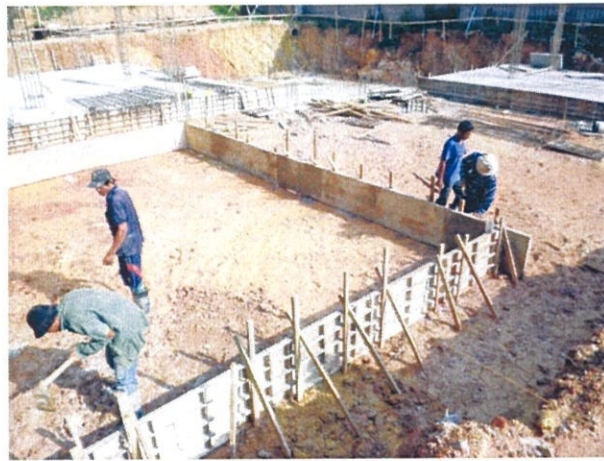
Gambar foto 3.9 Kerja membuat kotak acuan
