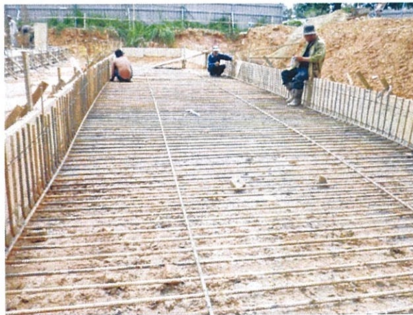
Gambar foto 3.33 Susunan besi tetulang menyilang
