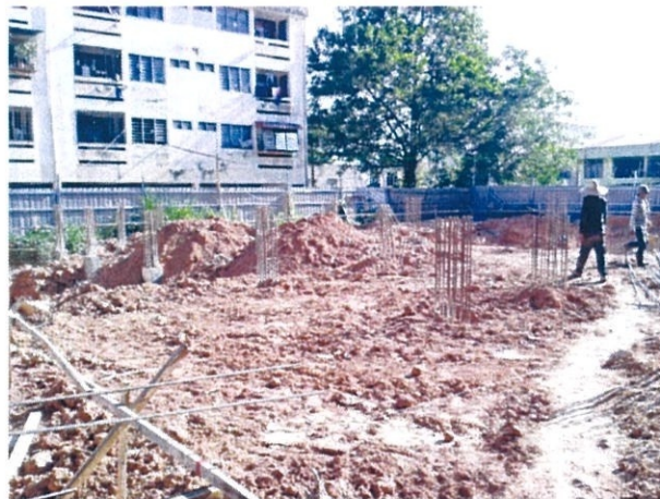
Gambar foto 3.38 Kerja mengambus asas jalur
