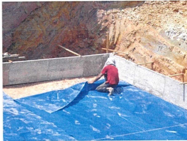
Gambar foto 3.10 Pemasangan plastik membran kalis air
