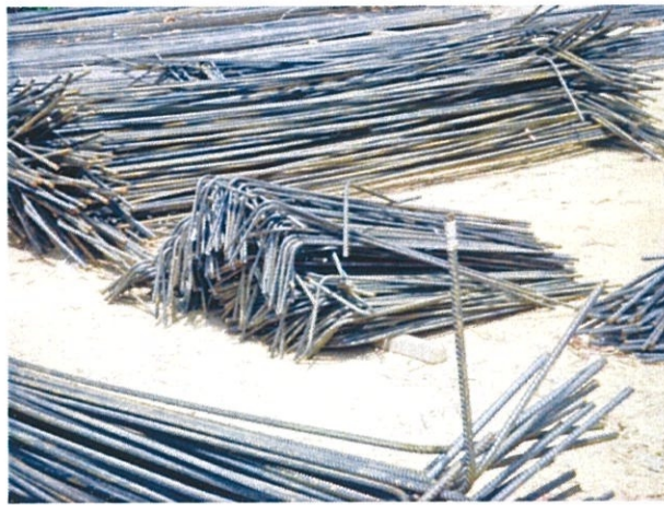
Gambar foto 3.11 Penyediaan besi tetulang asas
