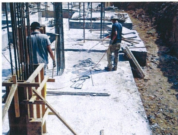
Gambar foto 3.26 Penyemburan anti-termite
