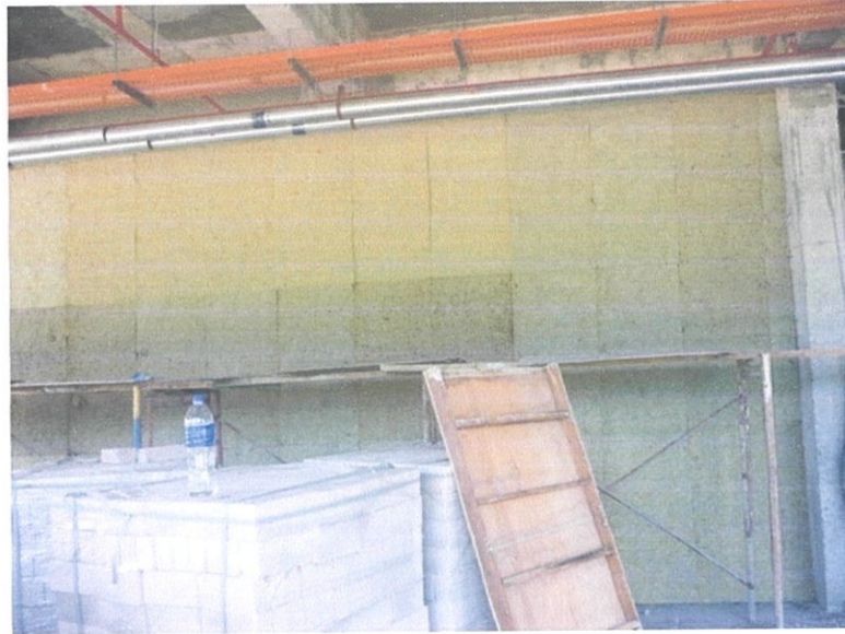
Gambar 4.2 Lapisan fiber disusun dan dipasang rapat memenuhi ruang permukaan dinding.
