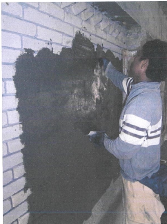
Gambar 3.8 Kerja-kerja lepaan setebal 20mm secara rawak.
