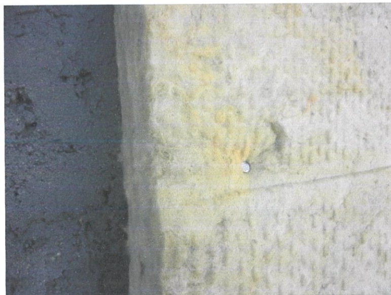
Gambar 4.1 Paku digunakan sebagai pengikat untuk pemasangan fiber . Foto Kredit: Mohamad Saufi (19 Ogos 2012).
