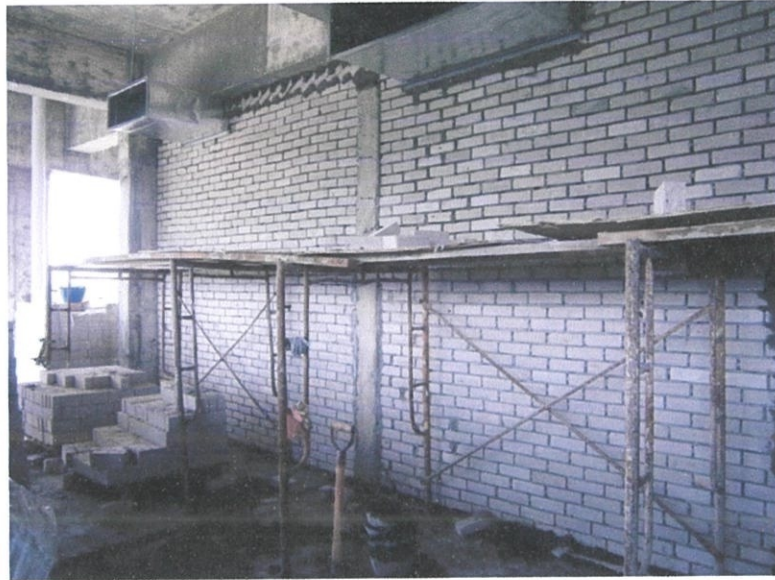
Gambar 3.7 Kerja-kerja mengikat bata yang telah disiapkan memenuhi ruang antara tiang ke tiang.
