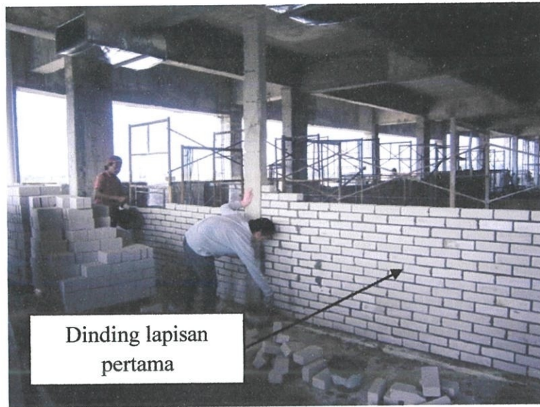
Gambar 3.5 Kerja-kerja mengikat bata untuk dinding lapisan pertama. Foto Kredit: Mohamad Saufi (26 Julai 2012).
