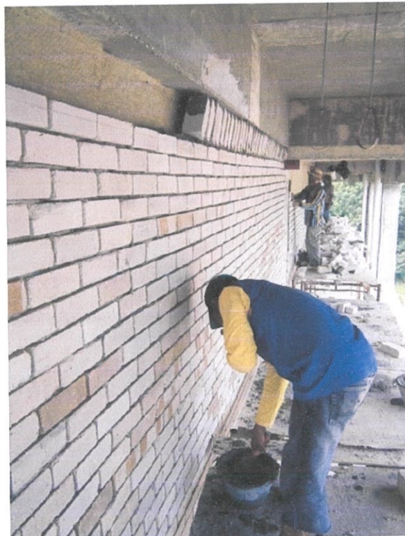
Gambar 4.7 Kerja-kerja mengikat Bata Kalsa bagi lapisan dinding yang kedua. Foto Kredit: Mohamad Saufi (31 Julai 2012).
