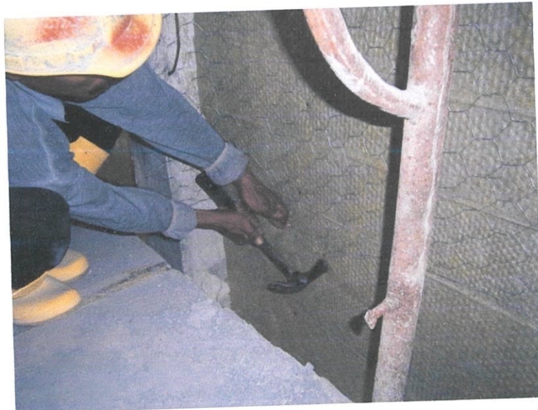
Gambar 4.5 Paku digunakan sebagai pengikat kawat kasa ( Wire Netting ). Foto Kredit: Mohamad Saufi (30 Julai 2012).
