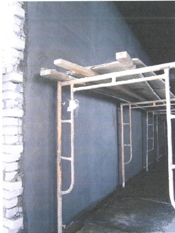
Gambar 4.8 Kerja-kerja lepaan terhadap keseluruhan permukaan dinding yang telah siap dibina.
