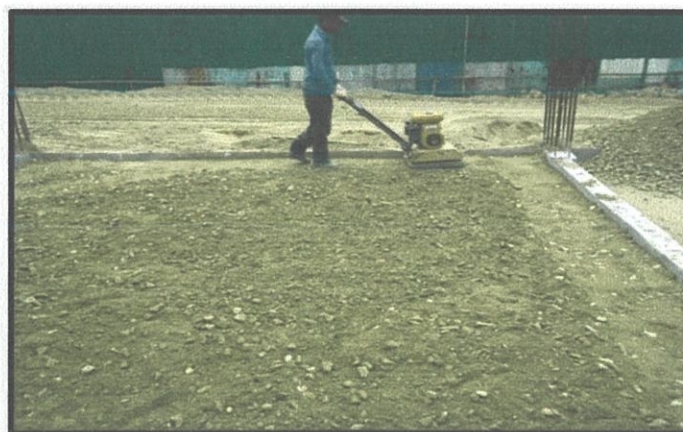
Gambar 3.9: Kerja-kerja memadatkan lapisan batu kelikir
