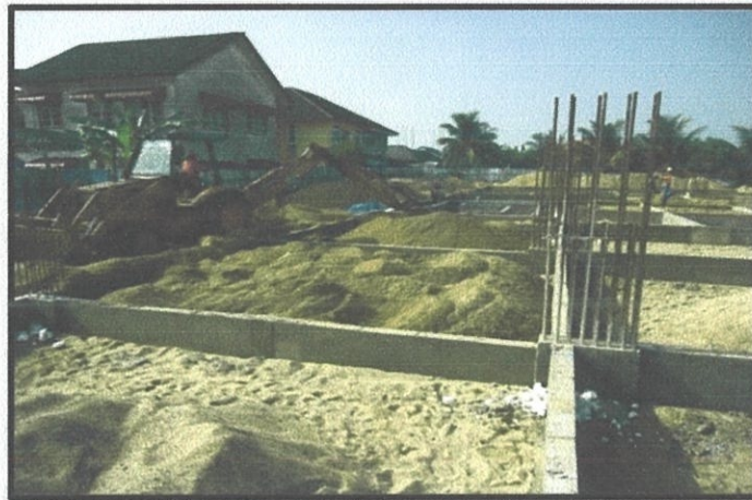
Gambar3.6: kerja-kerja memasukkan pasir
