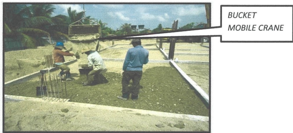
Gambar 3.8: kerja-kerja meratakan lapisan batu kelikir
