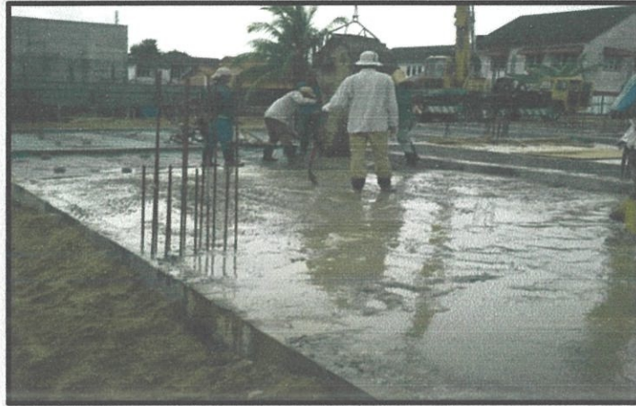
Gambar 3.16: kerja-kerja menuang konkrit
