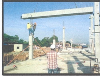
Gambar 3.12: Jurutera memantau memasukkan rasuk pada posisi yang betul Foto Kredit: Ridwan (7 April 2012)
