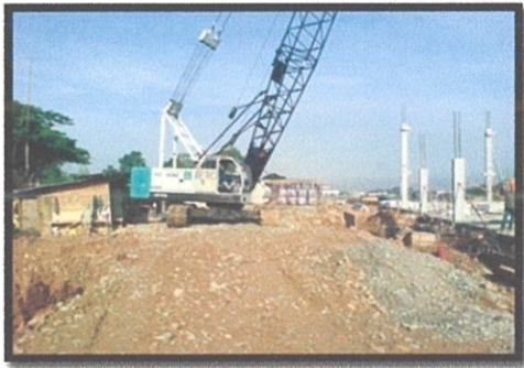
Gambar 3.9: Posisi Kren yang sesuai untuk mengangkat rasuk
