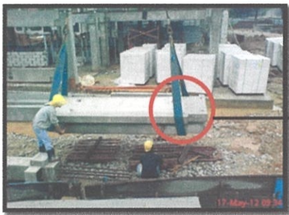
Gambar Foto 3.32: Belt digunakan dalam pemasangan pra – tuang.
