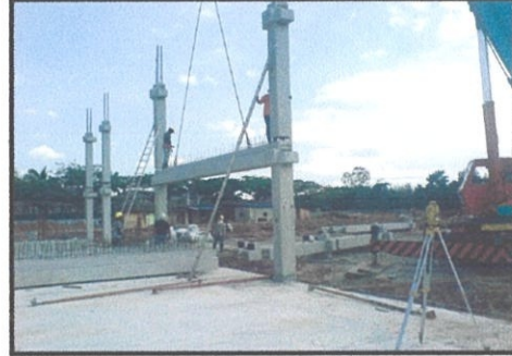
Gambar 3.7: Kecondongan tiang diukur menggunakan theodolite Foto Kredit: Ridwan (1 April 2012)
