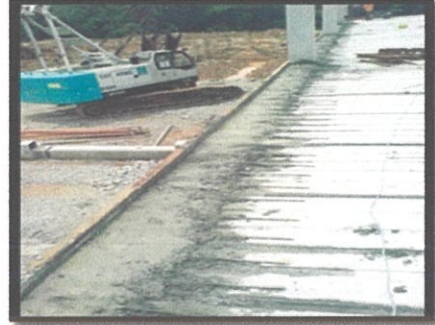
Gambar 3.25 : Keadaan lantai beronngga yang telah siap grouting
