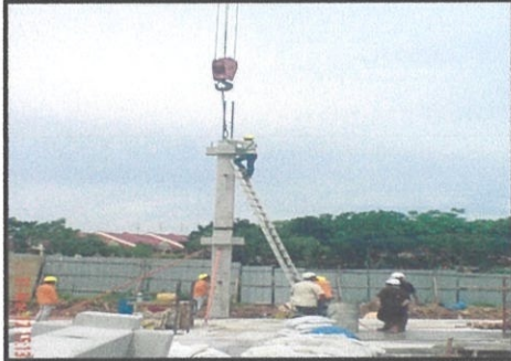
Gambar 3.6: Pekerja sedang menurunkan rantai besi pada tiang Foto Kredit: Ridwan (1 April 2012)
