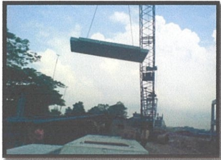
Gambar 3.13: Kren mengangkat landing slab menggunakan Foto Kredit: Ridwan (6 Jun 2012)
