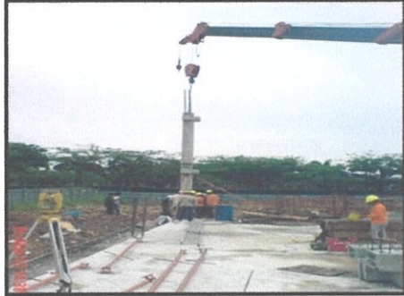
Gambar 3.4: Pekerja sedang meletakkan tiang di atas shimplate Foto Kredit: Ridwan (29 Mac 2012)
