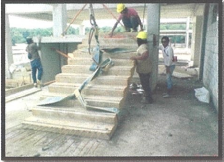
Gambar 3.15 : Pemasangan tangga pada landing slab
