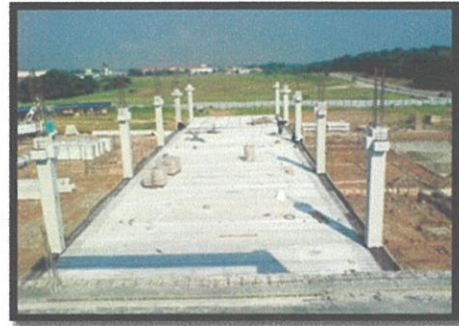
Gambar 3.23: Lantai yang telah siap dipasang mengikut spesifikasi Foto Kredit: Ridwan (8 Mei 2012)
