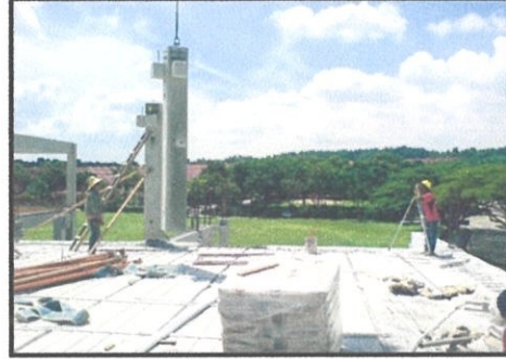
Gambar 3.5: Kedudukan tiang perlulah dalam keadaan vertical Foto Kredit: Ridwan (30 Mac 2012)
