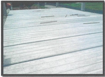
Gambar 3.22: Lantai pra – tuang pada kedudukan neoprene pad Foto Kredit: Ridwan (8 Mei 2012)
