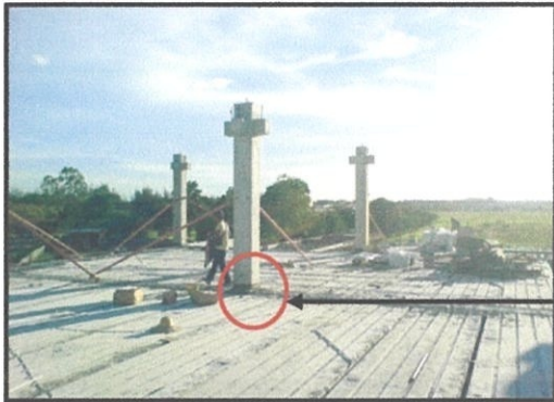
Gambar 3.8 : Non shrink grout diletakkan dibawah tiang pra – tuang
