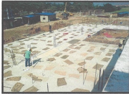
Gambar 3.17 : Kerja – kerja setting out untuk lantai berongga sedang dijalankan oleh pekerja
