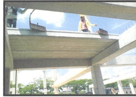
Gambar 3.21 :Pekerja memegang dan mengawal lantai tersebut
