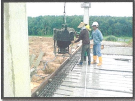
Gambar 3.24 : Proses grouting sedang dijalankan.
