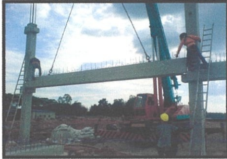
Gambar 3.11: Pekerja memegang rasuk pra – tuang dan mengawalnya Foto Kredit: Ridwan (7 April 2012)
