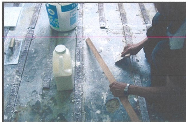
Gambar 3.35 Pemasangan kayu meter Foto Kredit: Asrul Asari (4 Januari 2012).
