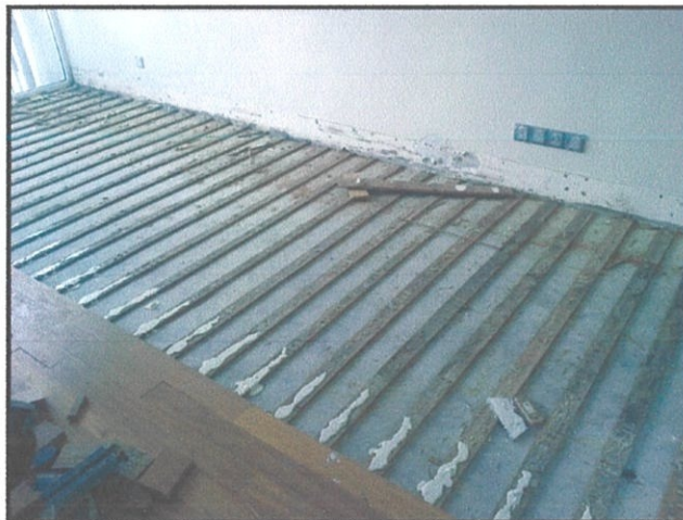
Gambar 3.37 Pemasangan kayu lantai Foto Kredit: Asrul Asari (4 Januari 2012).
