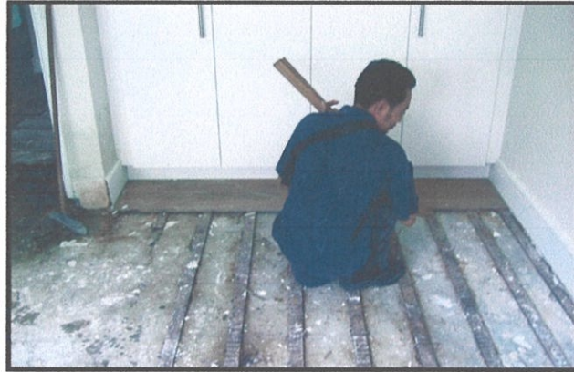
Gambar 3.34 Penetapan garisan permulaan Foto Kredit: Asrul Asari (4 Januari 2012).
