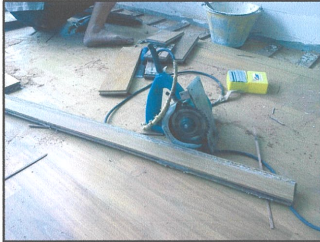
Gambar 3.38 Pemotongan kayu lantai Foto Kredit: Asrul Asari (4 Januari 2012).
