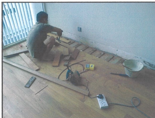
Gambar 3.41 Pemasangan kayu lantai Foto Kredit: Asrul Asari (4 Januari 2012).
