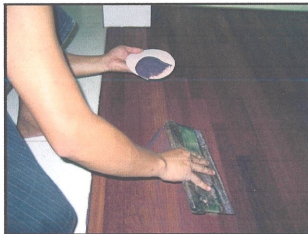
Gambar 3.52 Pemasangan woodfill
