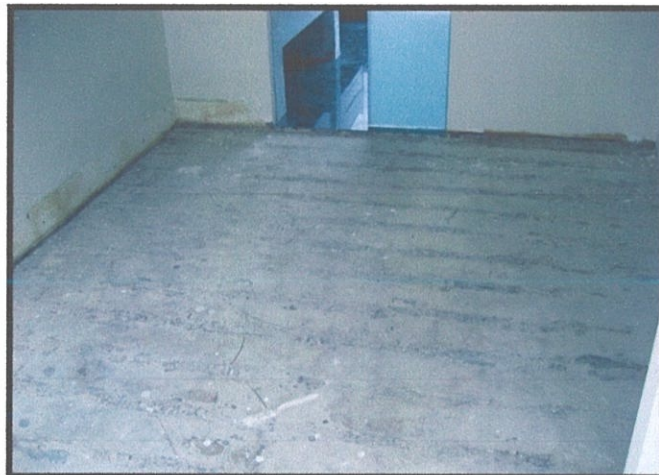
Gambar 3.1 Pemerhatian tapak kerja pemasangan lantai kayu Foto Kredit: Asrul Asari (23 Disember 2011).
