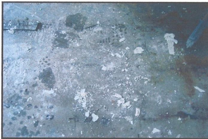
Gambar 3.3 Pemerhatian tapak kerja pemasangan lantai kayu Foto Kredit: Asrul Asari (23 Disember 2011).
