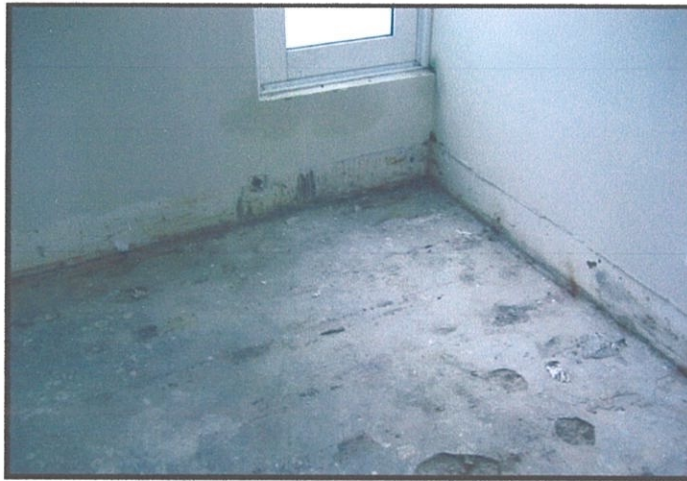
Gambar 3.2 Pemerhatian tapak kerja pemasangan lantai kayu Foto Kredit: Asrul Asari (23 Disember 2011).
