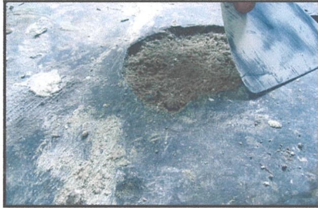
Gambar 3.33 Meratakan sub lantai Foto Kredit: Asrul Asari (4 Januari 2012).
