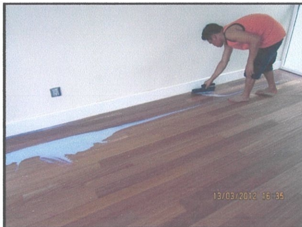
Gambar 3.50 Kerja menyapu water base polyurethena
