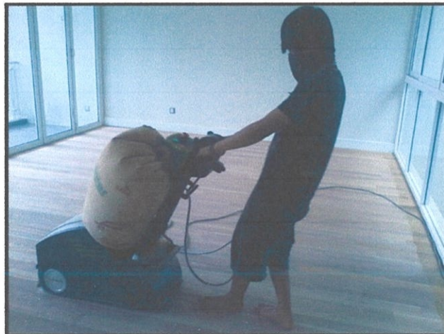
Gambar 3.42 Kerja mengempelas Foto Kredit: Asrul Asari (6 Januari 2012).
