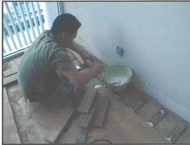
Gambar 3.40 Pemasangan kayu lantai Foto Kredit: Asrul Asari (4 Januari 2012).
