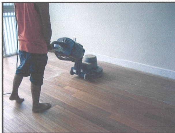
Gambar 3.53 Kerja menggosok lantai menggunakan penggosok karpet Foto Kredit: Asrul Asari (13 Mac 2012).
