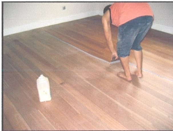
Gambar 3.55 Menyapu water base polyurethana peringkat kedua Foto Kredit: Asrul Asari (13 Mac 2012).
