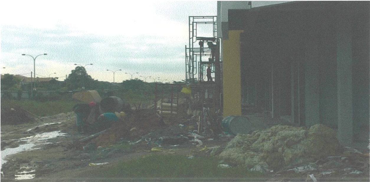
Gambar 1.9 Susun Atur dan Kedudukan Sisa Binaan Parkland, Klang
