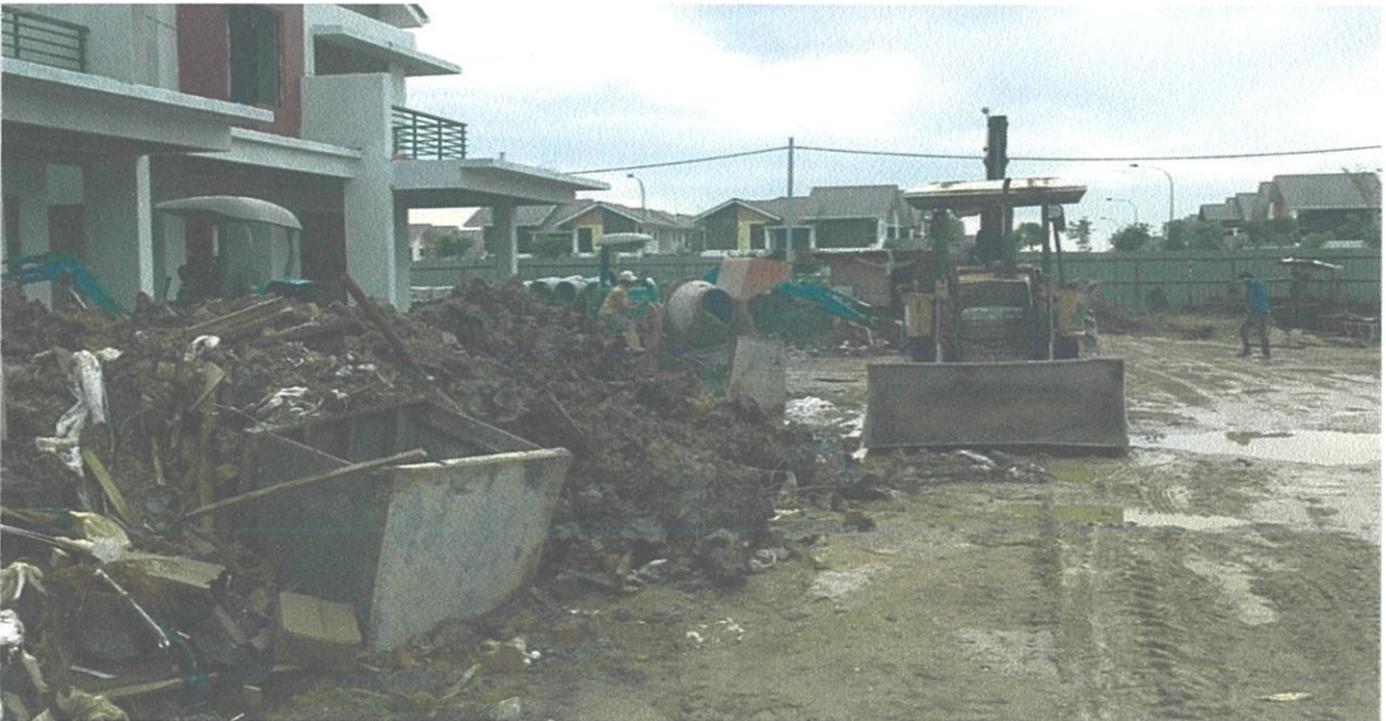
Gambar 1.14 Susun Atur dan Kedudukan Sisa Binaan Parkland, Klang
