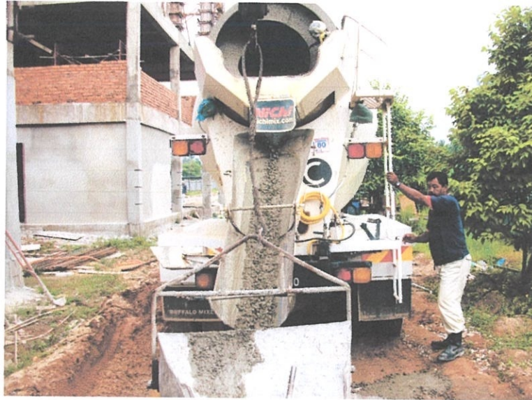
Foto 3.3: Proses penuangan konkrit ke dalam skip
