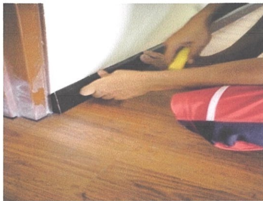
Rajah 4.2.7c– Pemasangan 'Skirting'
