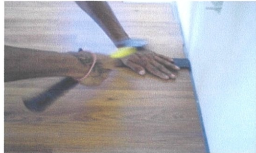
Rajah 4.2.4b– Kaedah Mengetatkan Barisan Papan Lantai Laminat
