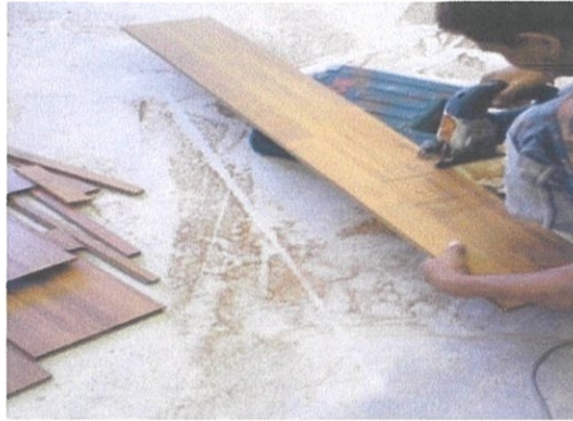
Rajah 4.2.2a– Pemotongan Papan Kayu Laminat
