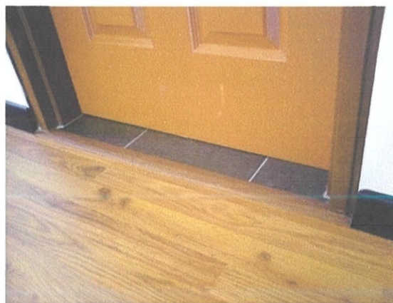
Rajah 4.2.6c – Selepas pemasangan 'Woodhauz'
