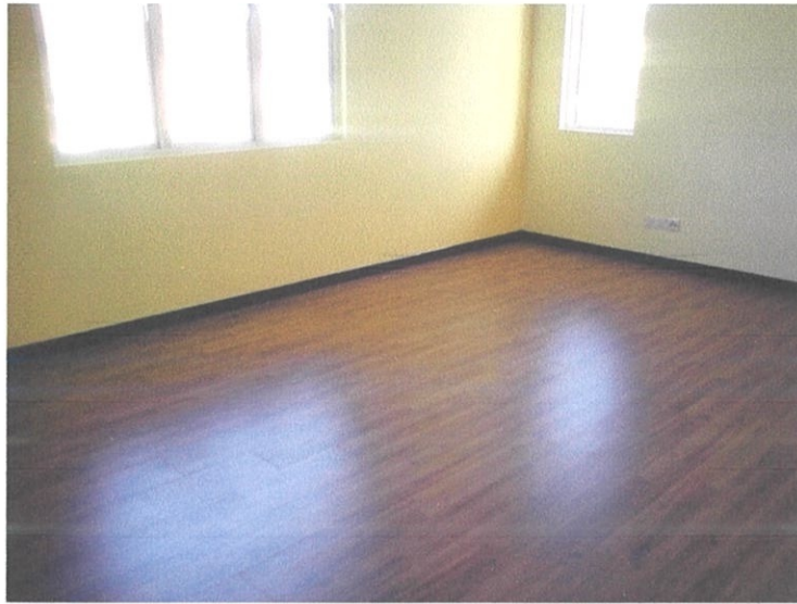
Rajah 4.2.7d– Lantai Kayu Laminat (Siap dipasang)
