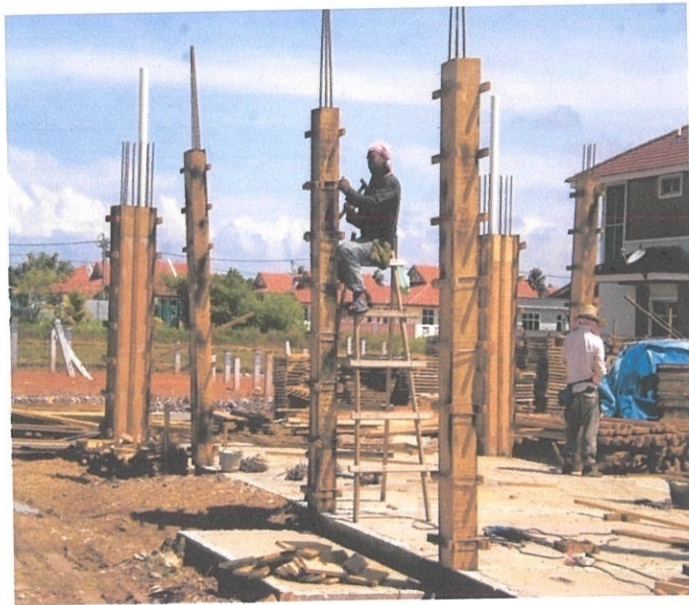
Rajah 4.23 Pemasangan Acuan Tiang Tingkat Bawah
