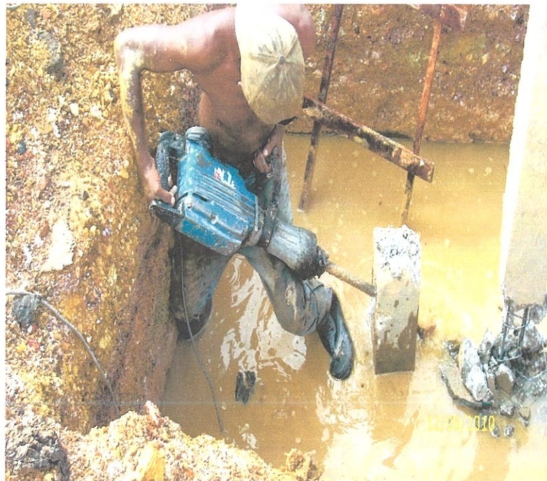
Rajah 4.6 Kerja Pemotongan Cerucuk
