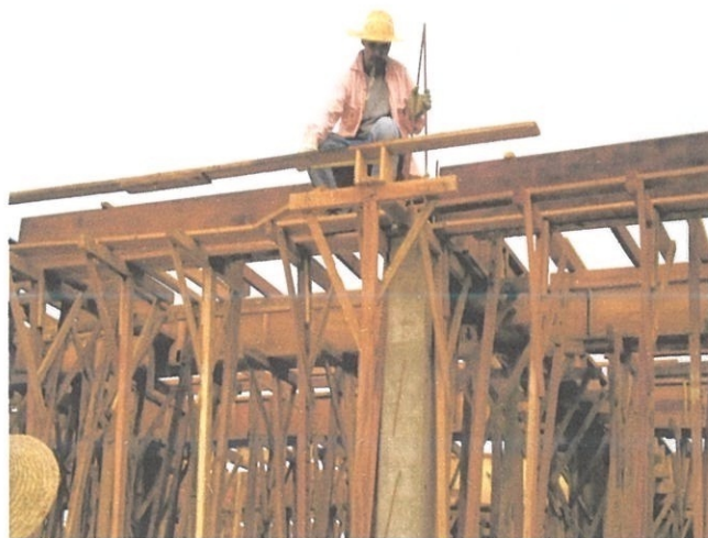
Rajah 4.26 Pemasangan Rasuk Lantai Tingkat Satu
