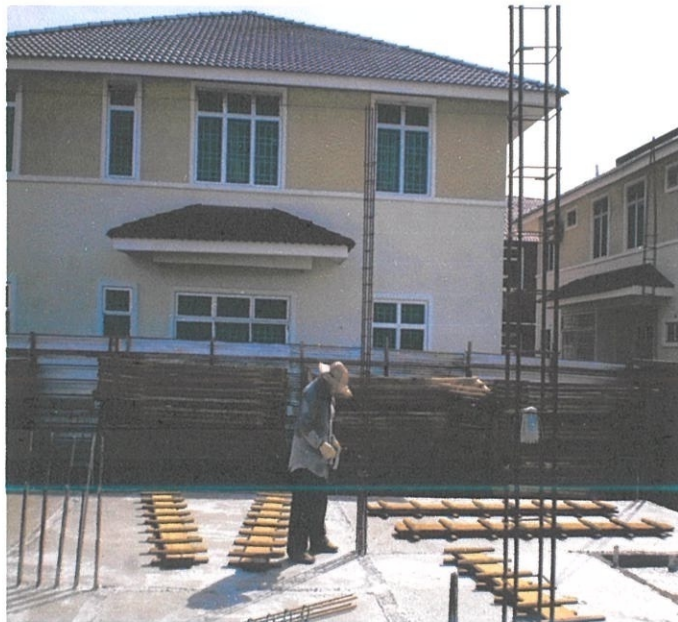
Rajah 4.22 Kerja Pemasangan Besi Tetulang Untuk Tiang Tingkat Bawah
