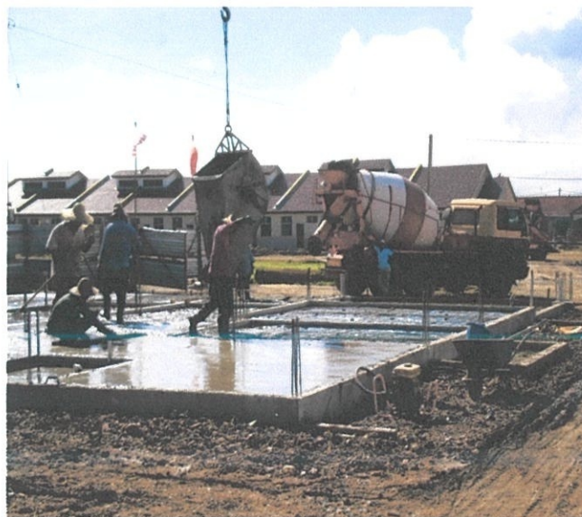
Rajah 4.21 Kerja Meratakan Lapisan Konkrit
