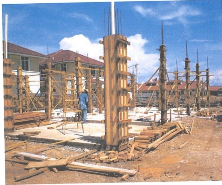
Rajah 4.24 Pemasangan Acuan Tiang
