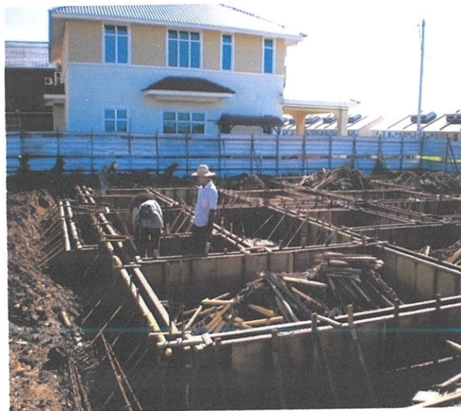
Rajah 4.10 Pemasangan Acuan Rasuk Lantai Bawah
