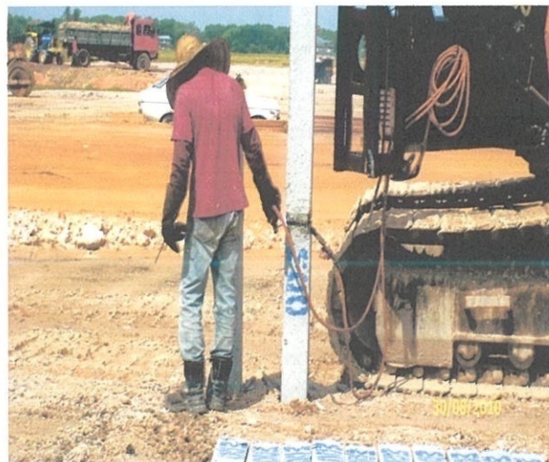
Rajah 4.2 Kerja Penyambungan Cerucuk Menggunakan Kaedah Wellding
