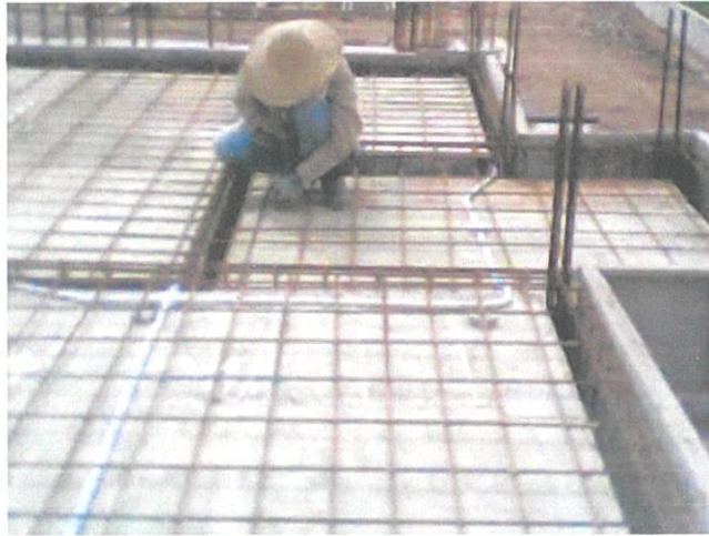
Rajah 4.29 Kerja Pemasangan besi tetulang untuk lantai
