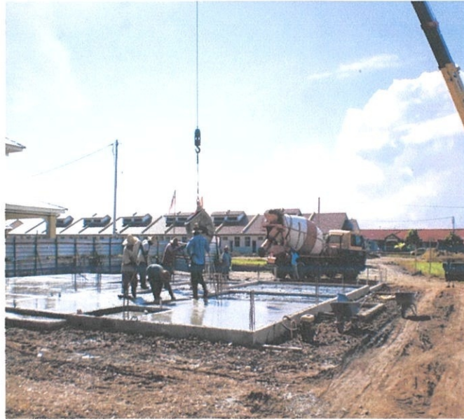
Rajah 4.20 Kerja Konkrit Untuk Lantai Tingkat Bawah
