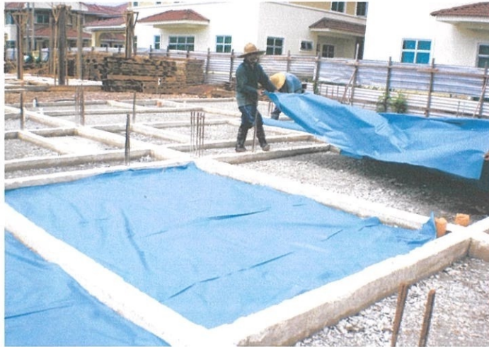
Rajah 4.18 Pemasangan Plastik Kalis Air
