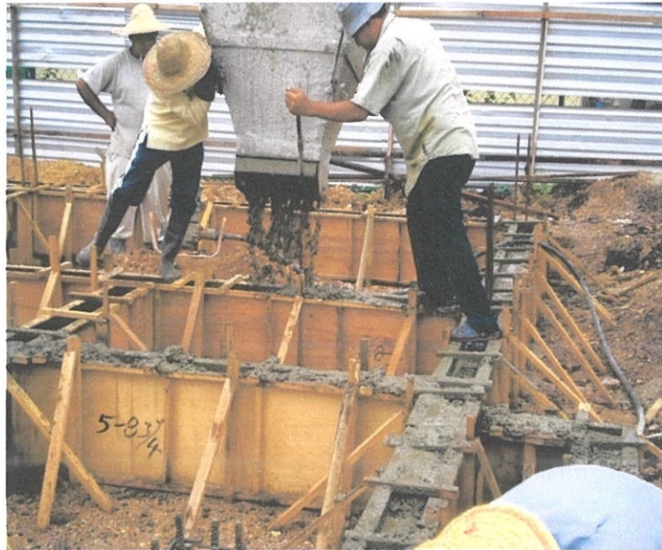
Rajah 4.13 Kerja Konkrit Rasuk Lantai Bawah
