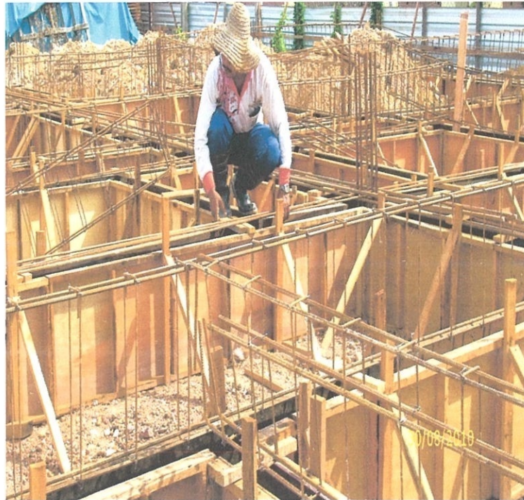
Rajah 4.12 Kerja Mengikat Besi Tetulang Untuk Lantai Rasuk Bawah
