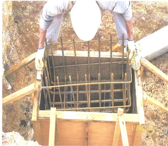
Rajah 4.8 Kerja Memasukkan besi tetulang didalam acuan 'Pile Cap'
