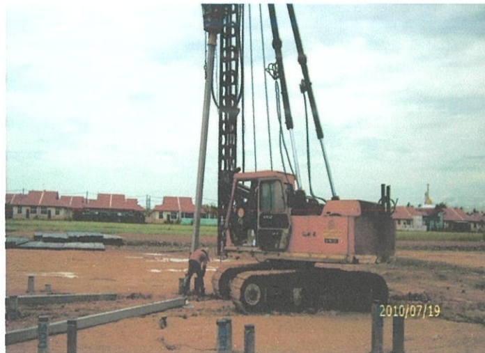
Rajah 4.3 Kerja Penanaman Cerucuk Menggunakan Mesin Cerucuk
