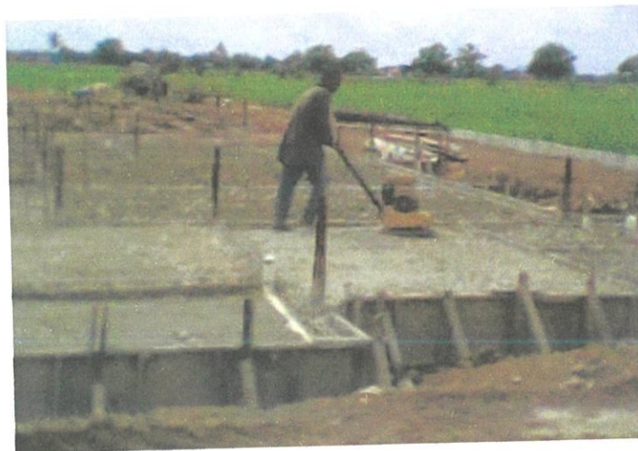
Rajah 4.16 Kerja Memadat Batu Baur (Hardcore)
