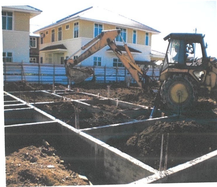
Rajah 4.15 Kerja Tanah Di Masukkan Dalam Rasuk Lantai
