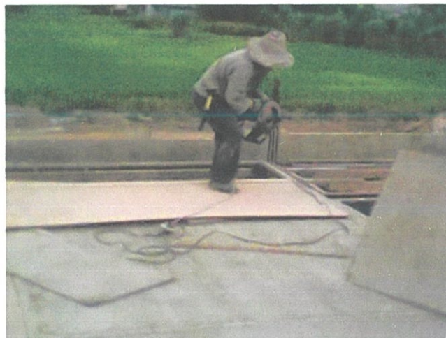
Rajah 4.28 Kerja Pemasangan papan lantai
