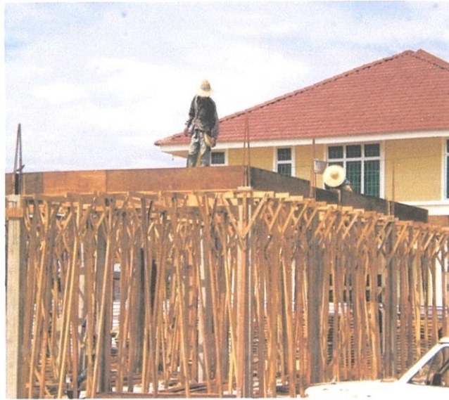
Rajah 4.27 Kerja Pemasangan Acuan Rasuk Lantai Tingkat Atas
