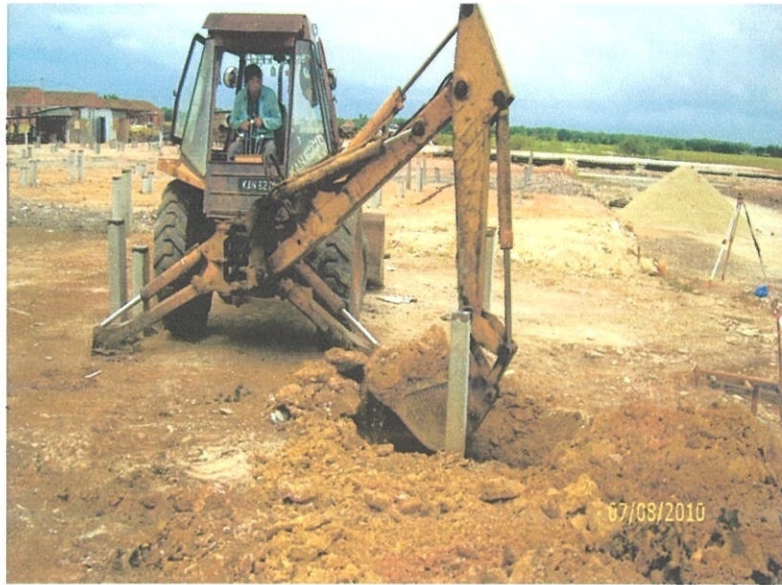
Rajah 4.4 Kerja-kerja pengorekkan asas
