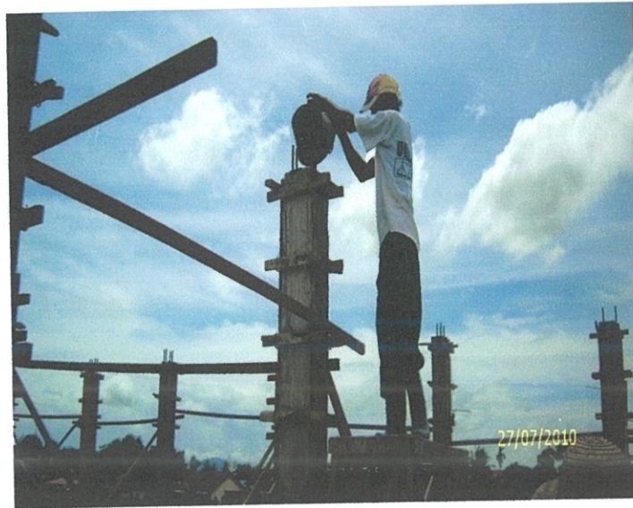
Rajah 4.25 Kerja Mengkonkrit Tiang Tingkat Bawah
