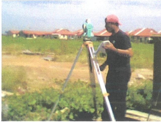
Rajah 4.1 Kerja-kerja Mengambil Bacaan Level Untuk Point Cerucuk
