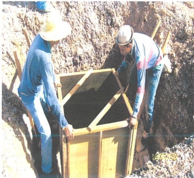
Rajah 4.7 Kerja Pemasangan Acuan Untuk 'Pile Cap'
