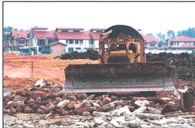
Gambar foto 4.6 : Pembinaan jalan sementara.
