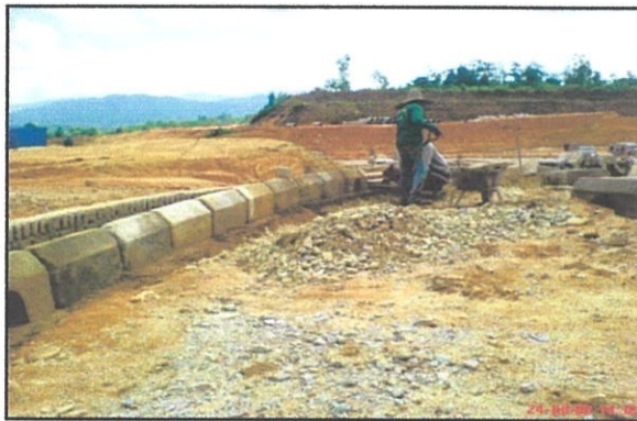
Gambar foto 4.14 : Pemasangan ' Kerb '
