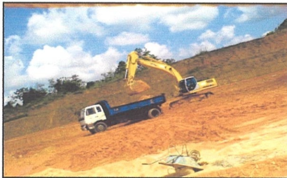
Gambar foto 4.9 : Kerja pemotongan tanah.
