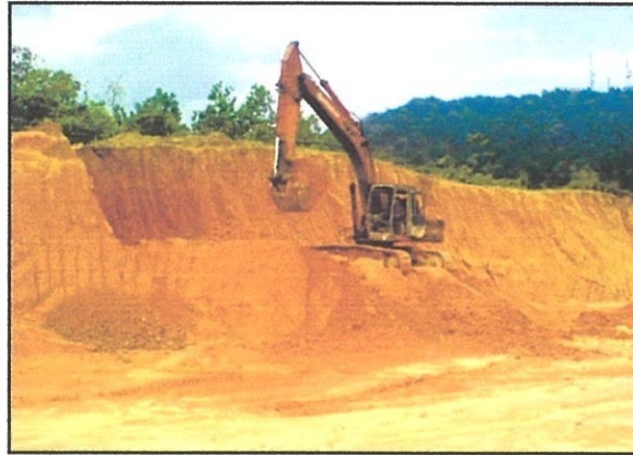
Gambar foto 4.4 : Proses pembuangan tanah atas
