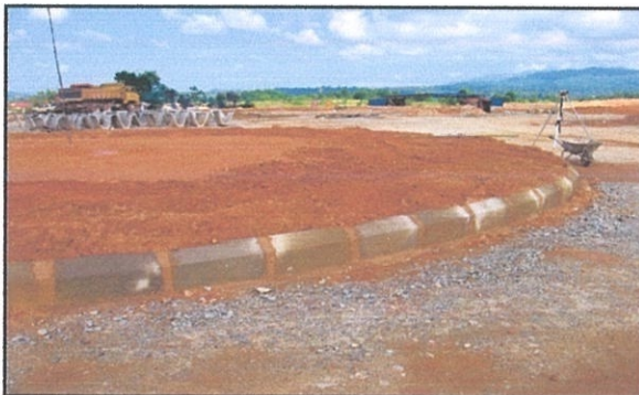
Gambar foto 4.15 : ' Kerb ' dikawasan ' roundabout '.
