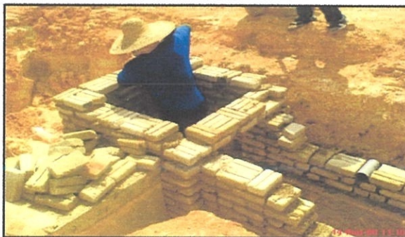
Gambar foto 4.13 : Kerja pembinaan takungan atau 'sum'
