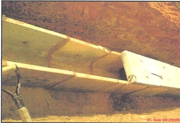
Gambar foto 4.12 : Proses pemasangan 'box culvert'.
