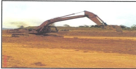
3. KERJA TANAH Pemotongan dan penambakan
