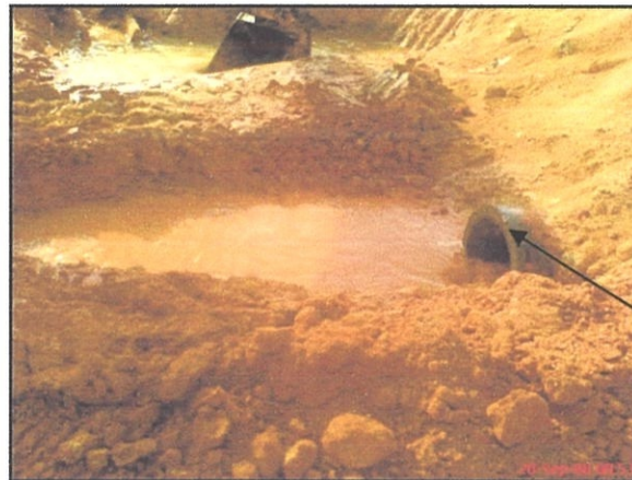
Gambar foto 5.8 : Pembinaan saluran sementara
