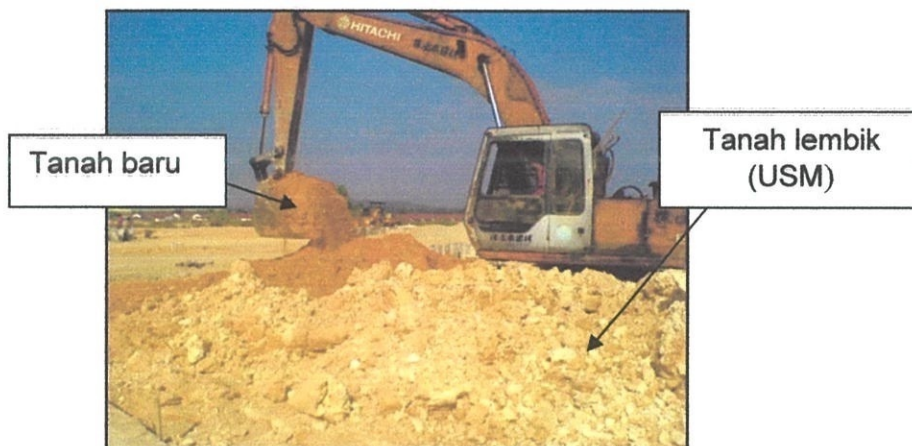
Gambar foto 5.2 : Pengorekan tanah lembik
