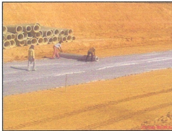
Gambar foto 5.10 : Pemasangan polyfelt
