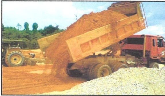
Gambar foto 4.10 : Kerja penambakan tanah
