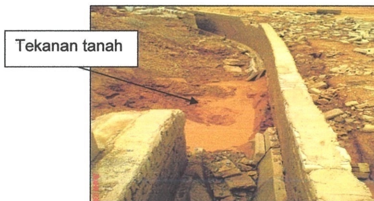
Gambar foto 5.3 : Kegagalan dinding bata.
