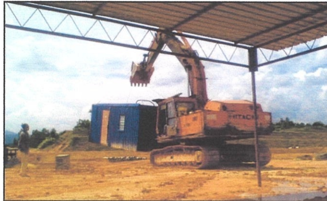
Gambar foto 4.7 : Kerja Pemasangan Kabin.
