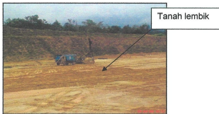
Gamabr foto 5.9 : Pemendapan tanah jalan
