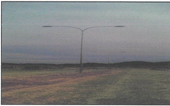
Gambar foto 4.20 : Pemasangan lampu jalan.
