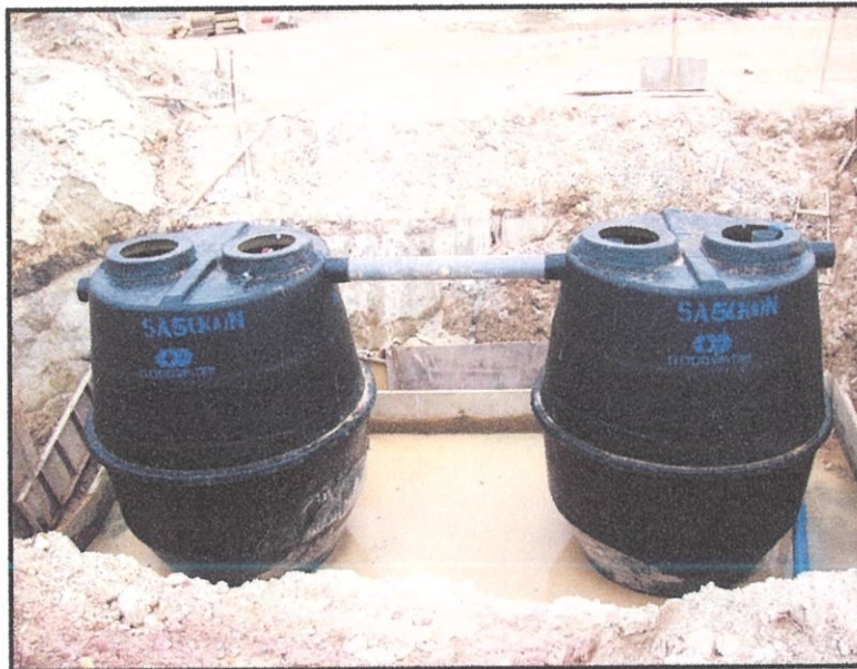
Gambarajah 4.4.10.8: Menunjukkan tangki septik yang telah diletakkan diatas tapak asas
