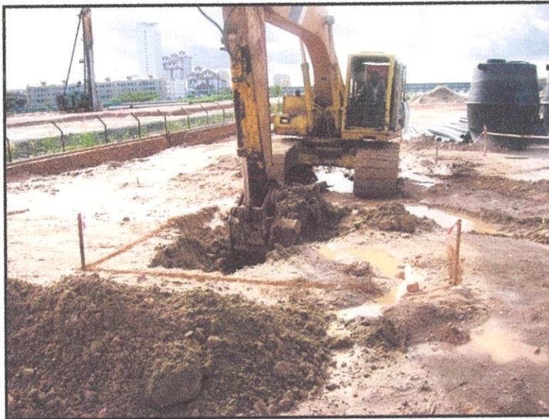
Gambarajah 4.5.1: Menunjukkan excavator yang digunakan untuk mengorek tapak asas tangki septik
