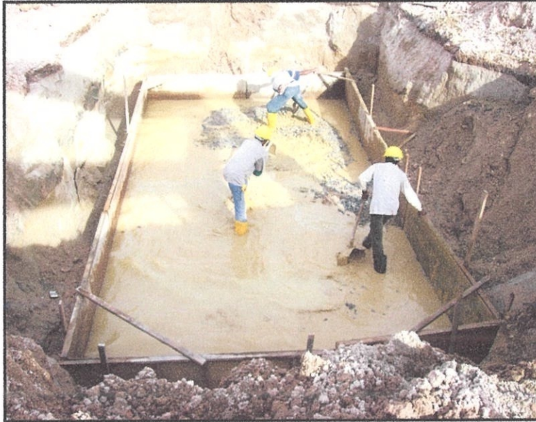
Gambarajah 4.4.7.3: Menunjukkan Proses meratakan crusher run
