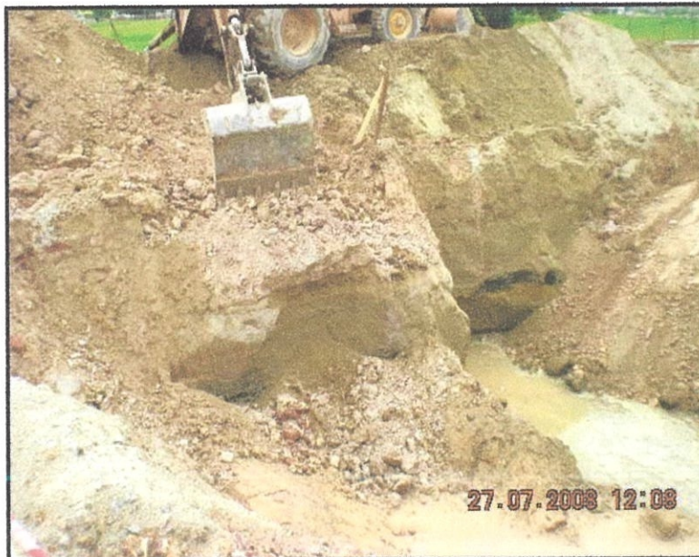
Gambarajah 5.3.4: Menunjukkan kerja membuat lereng
