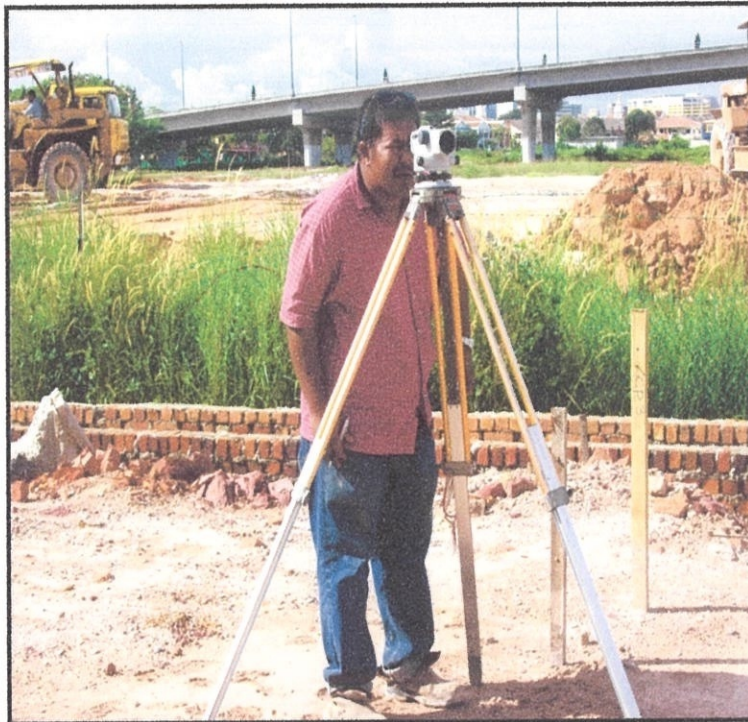
Gambarajah 4.4.2.1: Menunjukkan juruukur menentukan kedudukan tapak asas
