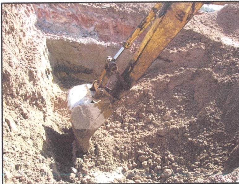
Gambarajah 4.4.3.3: Menunjukkan kerja-kerja pengorekan
