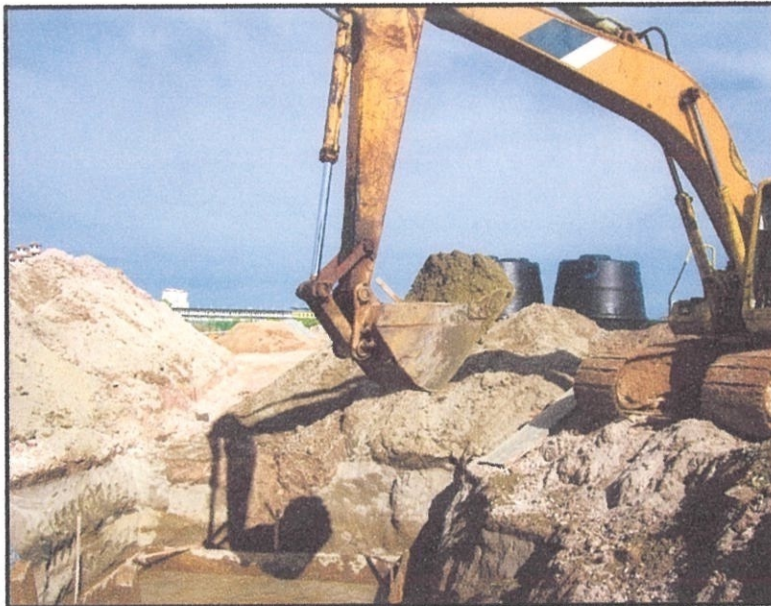
Gambarajah 4.4.8.1: Menunjukkan lean conrit dimasukkan ke dalam kotak acuan
