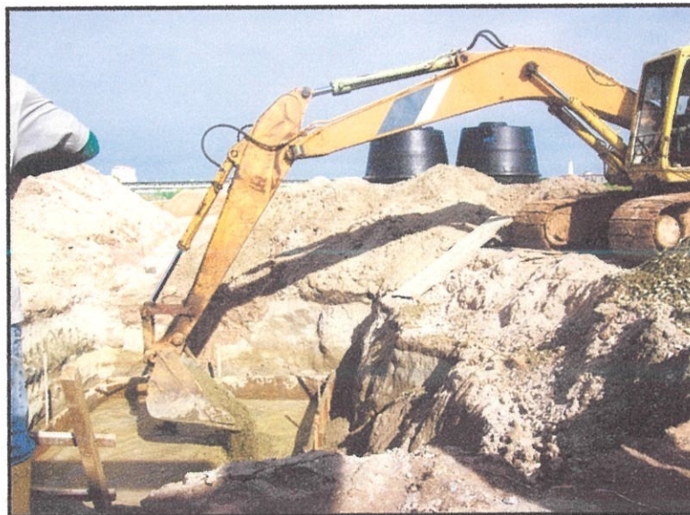
Gambarajah 4.4.7.2: Menunjukkan excavator memasukkan crusher ke dalam kotak acuan
