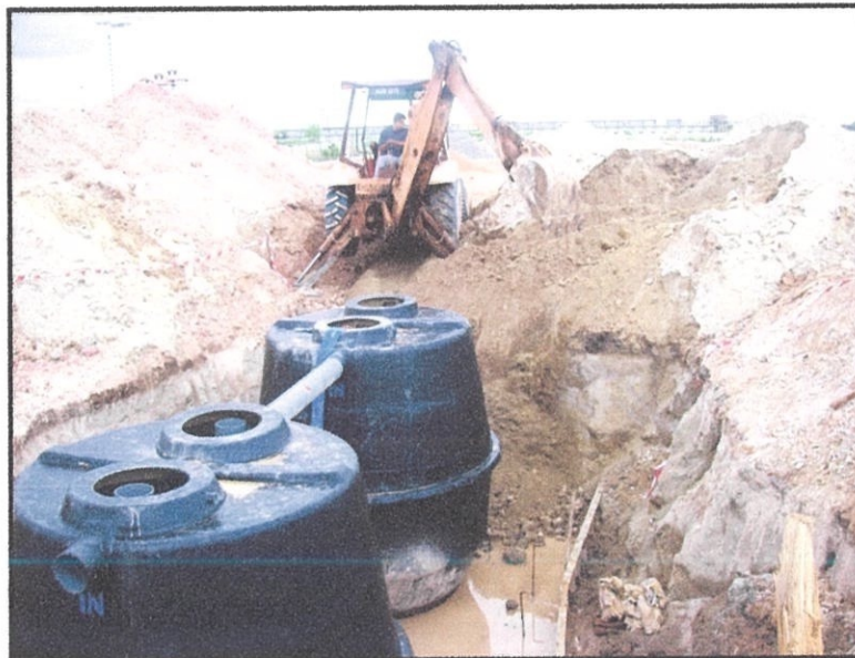
Gambarajah 4.4.10.10: Menunjukkan backhoe menimbus tanah kedalam kawasan tangki septik
