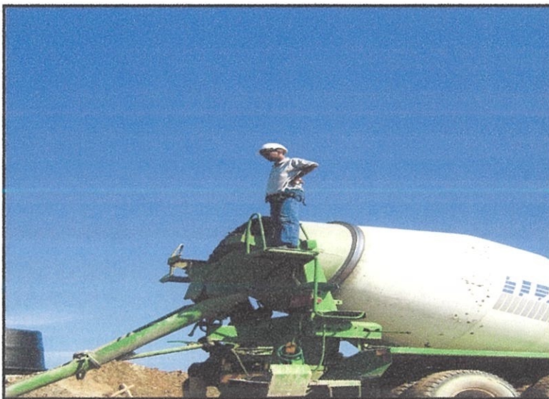
Gambarajah 4.4.10.5: Menunjukkan penyelia tapak mengawal kerja-kerja konkrit
