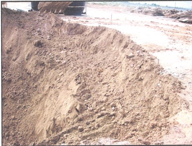
Gambarajah 4.4.4.1: Menunjukkan Lereng yang dibuat
