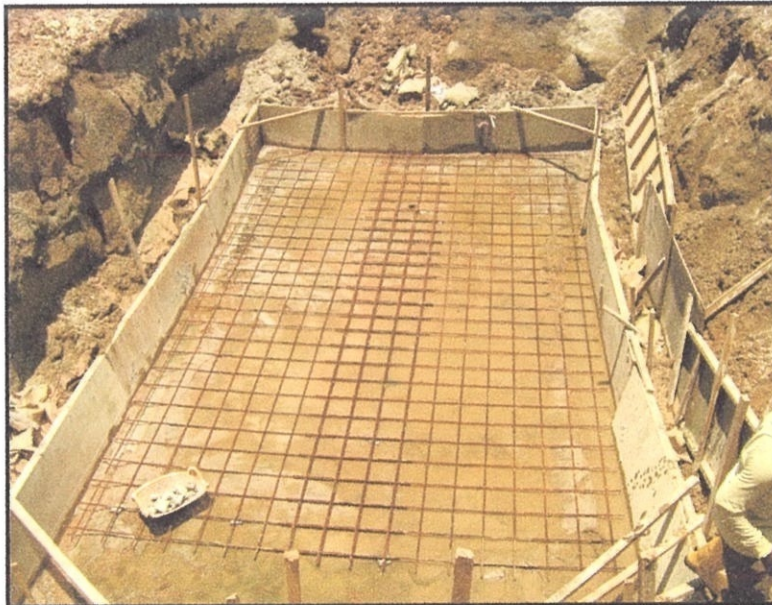
Gambarajah 4.4.9. 1: Menunjukkan pemasangan besi BRC
