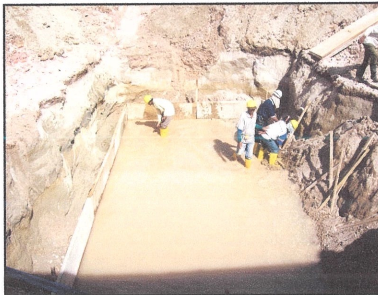
Gambarajah 4.4.6.2: Menunjukkan Pemasangan kotak acuan
