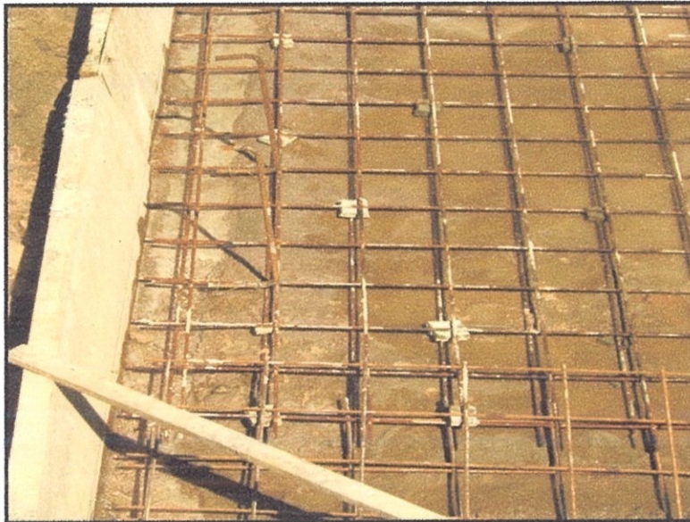
Gambarajah 4.4.9.2: Menunjukkan 'spacer block' yang diletakkan diantara lapisan atas dan bawah besi BRC
