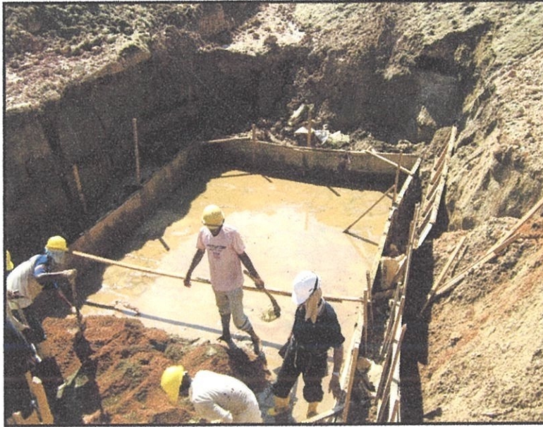
Gambarajah 4.4.8.2: Menunjukkan campuran pasir dan simen untuk dijadikan lean concret.
