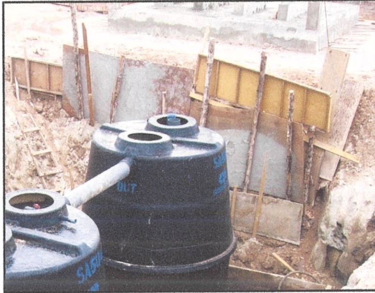
Gambarajah 5.3.3: Menunjukkan dinding penahan yang dibuat
