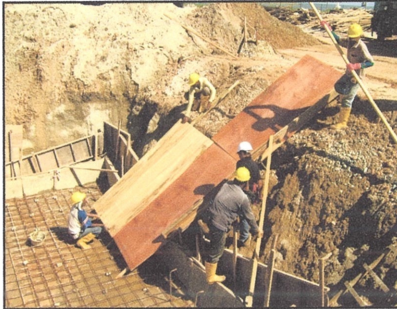
Gambarajah 4.4.10. 2: Menunjukkan kerja-kerja menyiapkan ‘chut’
