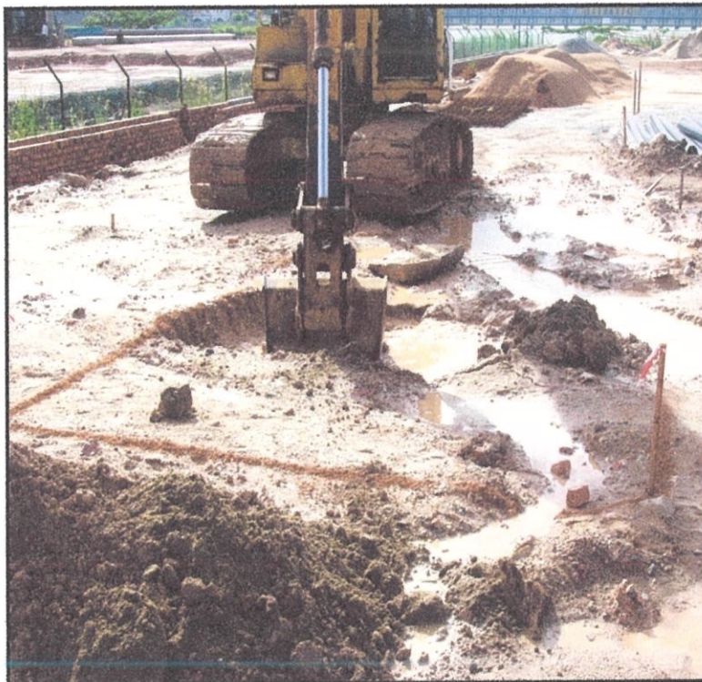
Gambarajah 4.4.3.1: Menunjukkan Kerja-kerja pengorekan
