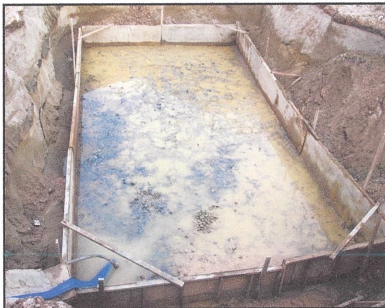
Gambarajah 4.4.7.4: Menunjukkan Crusher yang telah diratakan didalm kotak acuan
