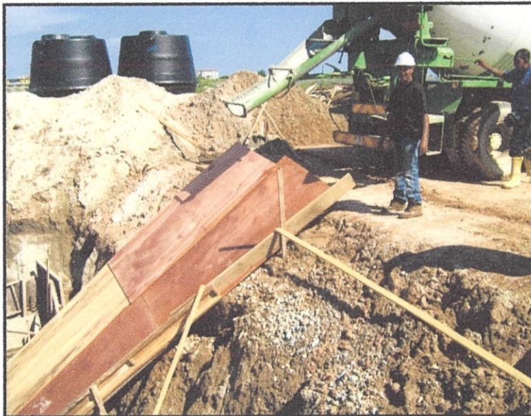
Gambarajah 4.4.10. 1: Menunjukkan penuangan konkrit dijalankan
