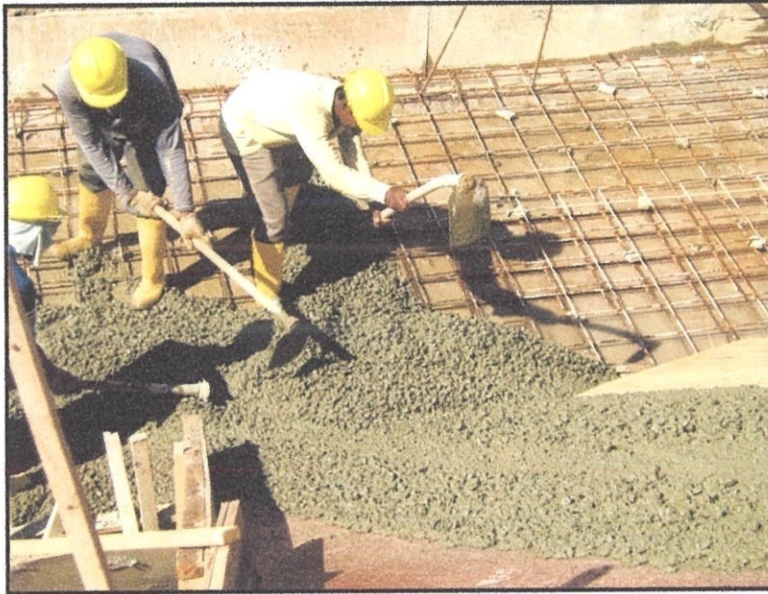
Gambarajah 4.4.10. 6: Menunjukkan konkrit dituang kedalam kotak acuan tapak asas.
