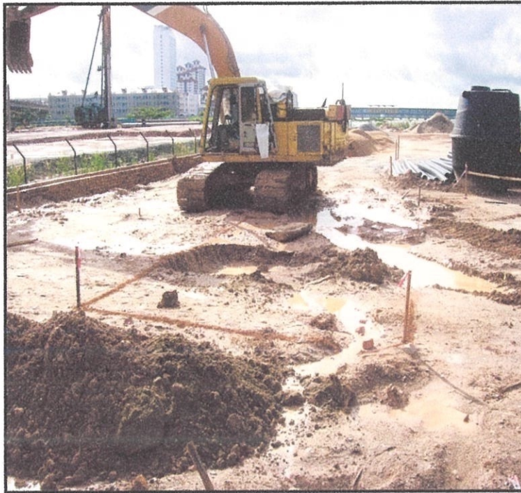
Gambarajah 4.4.2.2: Menunjukkan kerja-kerja ukur dan penandaan kedudukan tapak asas dijalankan
