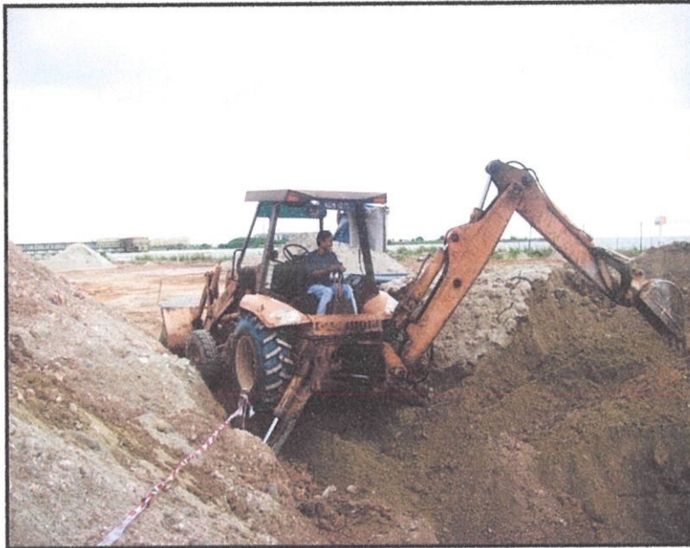
Gambarajah 4.5.2: Menunjukkan backhoe yang digunakan untuk membuat lereng
