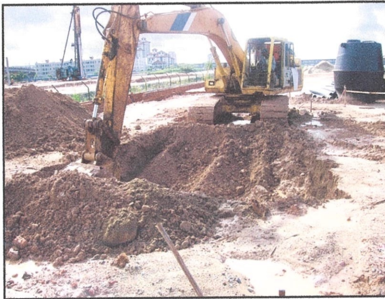
Gambarajah 4.4.3.2: Menunjukkan kerja-kerja pengorekan
