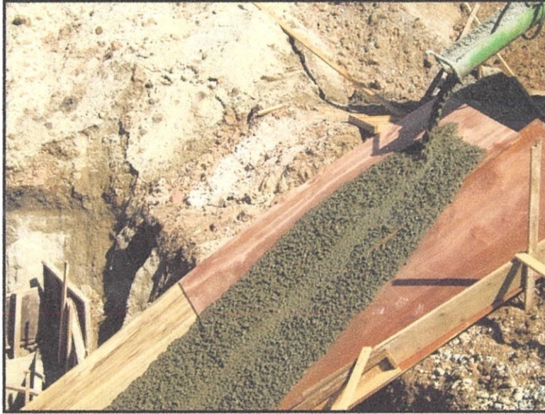
Gambarajah 4.4.10. 4: Menunjukkan proses penuangan konkrit menggunakan 'chut'.
