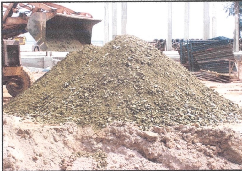
Gambarajah 4.4.7.1: Menunjukkan crusher run yang digunakan
