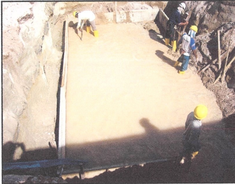
Gambarajah 4.4.6.1: Menunjukkan Pemasangan kotak acuan
