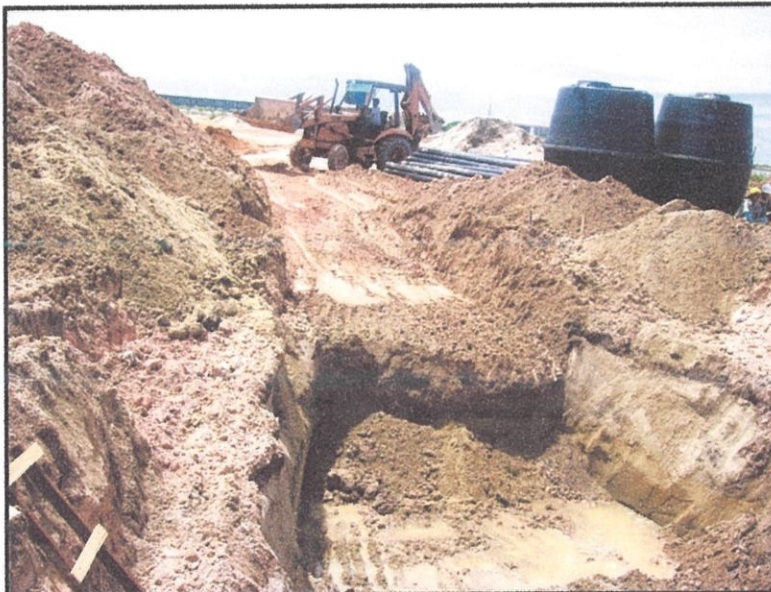
Gambarajah 4.4.4.2: Menunjukkan Backhoe membuat lereng
