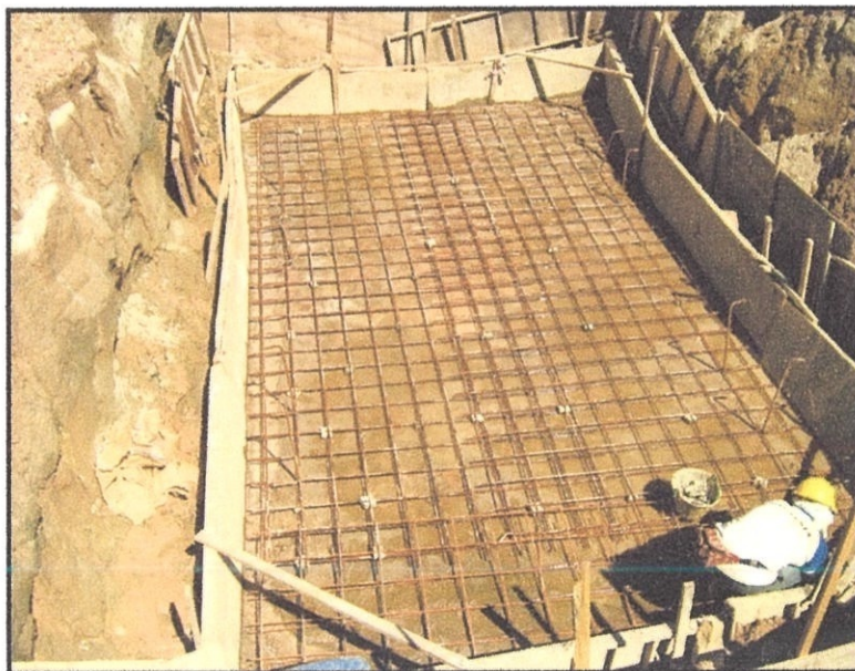
Gambarajah 4.4.9. 3: Menunjukkan besi BRC yang telah siap dipasang.
