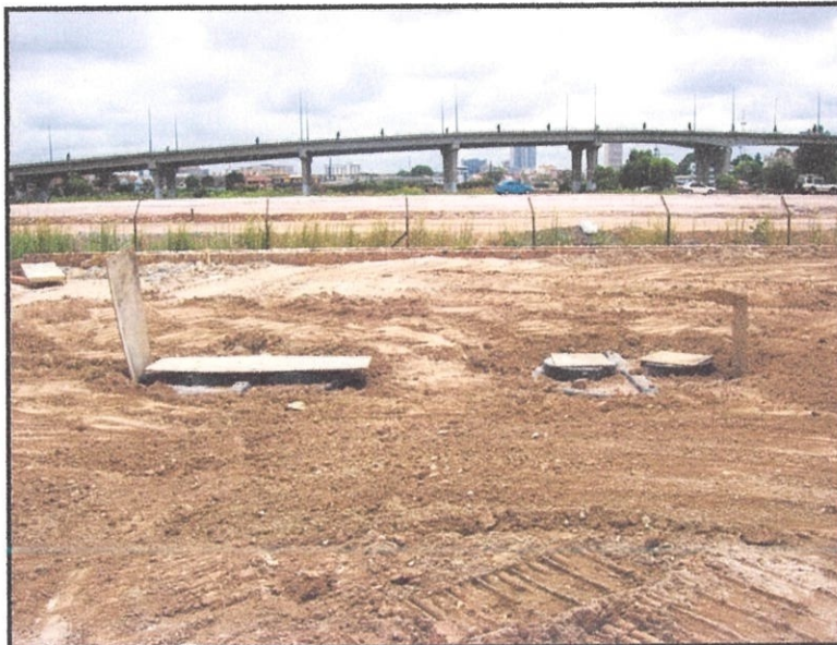
Gambarajah 4.4.10.12: Menunjukkan tangki septik yang telah ditimbus dan kawasan tangki septik yang telah diratakan.
