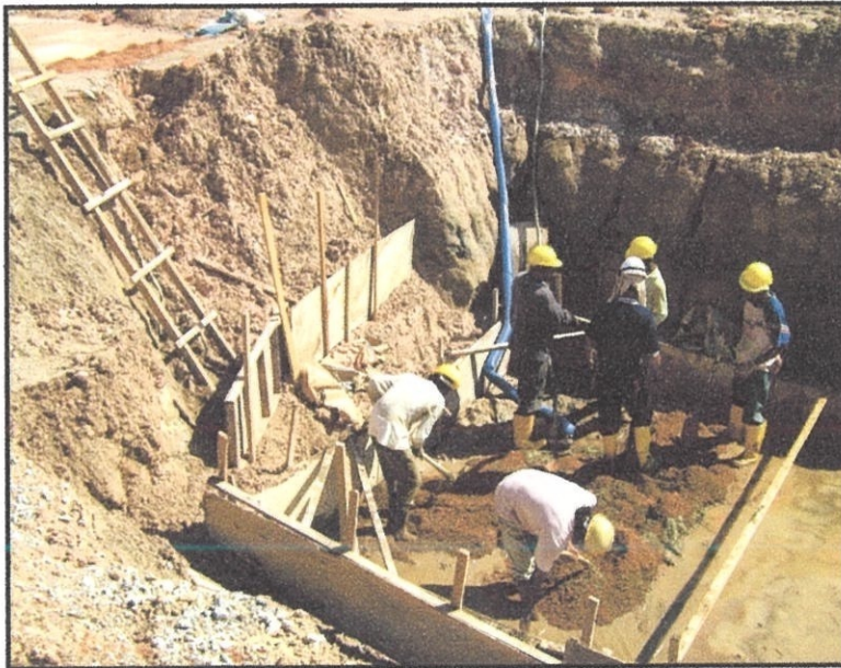
Gambarajah 4.4.8.3: Menunjukkan pasir dan simen di campur dengan air yang sedia ada dan dijadikan leanconcrit
