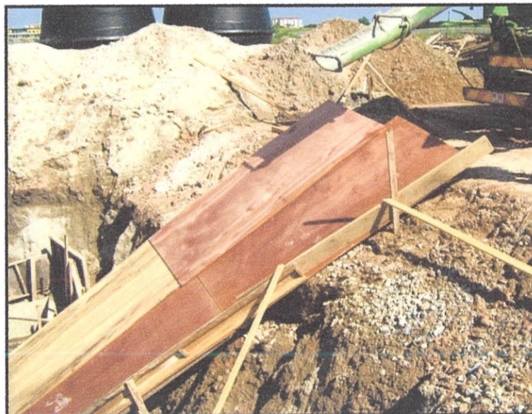
Gambarajah 4.4.10. 3: Menunjukkan ‘chut’ yang telah siap dibuat.
