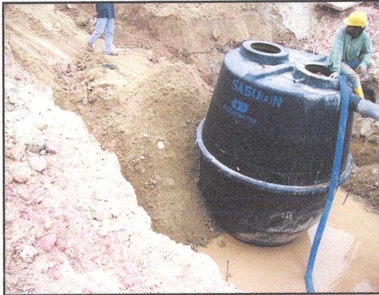
Gambarajah 4.4.10.9: Menunjukkan air dipam kedalam tangki septik
