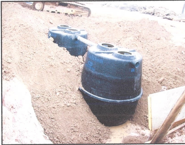
Gambarajah 4.4.10. 11: Menunjukkan kerja-kerja menimbus tanah
