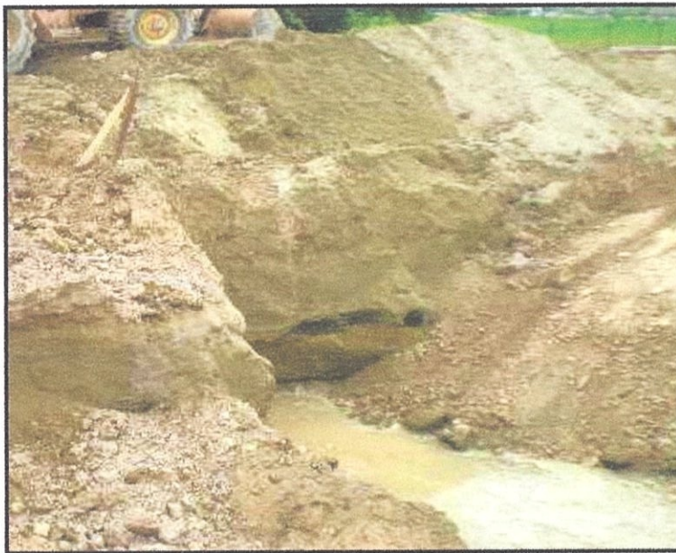
Gambarajah 5.2.2: menunjukkan lapisan bawah tanah yang berpasir
