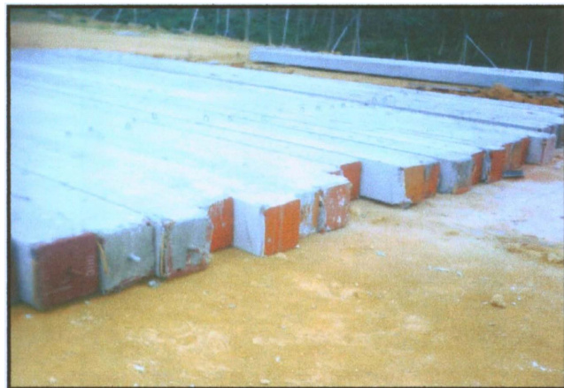
R.C3: CERUCUK KONKRIT BERTETULANG BERSAIZ 200X200MM YANG DIGUNAKAN BAGI PROJEK INI. (PROJEK PEMBINAAN TASKA, KG. BARU, SRI GADING BATU PAHAT JOHOR)
