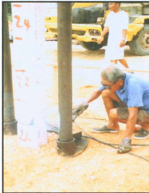
R.C5: KERJA PENGIMPALAN SEDANG DIJALANKAN BAGI KERJA PENYAMBUNGAN JENIS KONKRIT BERTETULANG
