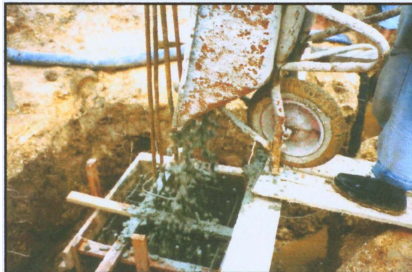
R.D2: KERJA-KERJA PENUANGAN KONKRIT KE DALAM TETOPI CERUCUK DILAKUKAN DENGAN CERMAT AGAR TIDAK BERLAKU SEBARANG PEMBAZIRAN)
