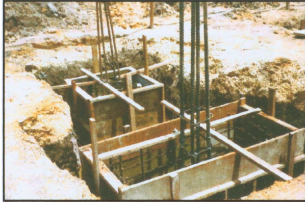
R.D1: TETOPI CERUCUK YANG DIPASANG DENGAN ACUAN DAN TELAH DIKAT DENGAN TETULANG BERSAIZ R 12, Y16.
