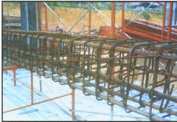
R.E4: TETULANG BAGI RASUK YANG TELAH DIIKAT DENGAN LINK (PROJEK PEMBINAAN TASKA, KG. BARU, SRI GADING BATU PAHAT JOHOR)
