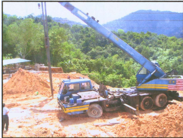
R.C2: MESIN PELANTAK (HYDRAULIC HAMMER) SEDANG MENJALANKAN AKTIVITI CERUCUK (PROJEK PEMBINAAN TASKA, KG. BARU SRI GADING, BATU PAHAT JOHOR)
