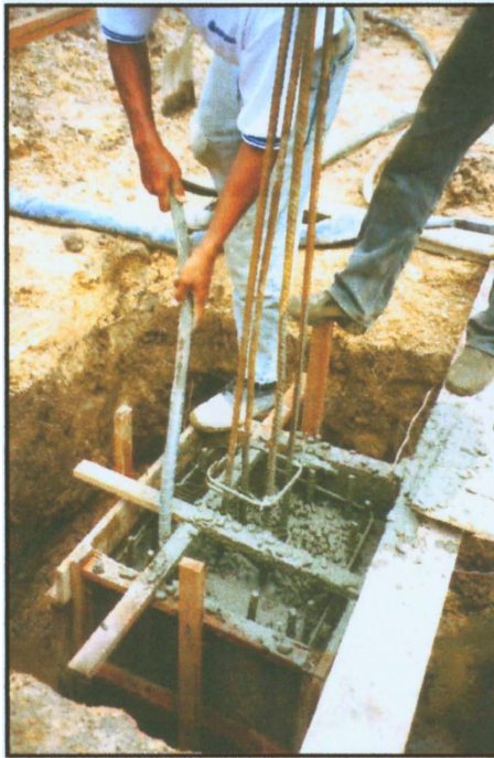
R.D3: KERJA-KERJA MEMAMPAT DAN MEMADATKAN KONKRIT DENGAN MENGUNAKAN MESIN PENGGETAR (PROJEK PEMBINAAN TASKA, KG. BARU, SRI GADING BATU PAHAT JOHOR)
