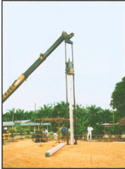
R.C4: KERJA-KERJA PENANAMAN CERUCUK BERNOMBOR A2 SEDANG DIJALANKAN DIMANA TENAGA HAMMER YANG DIKENAKAN ADALAH SEBANYAK 9.0KNM
