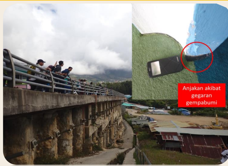
Gambar 7: Keadaan sekitar Masjid Kundasang dan gambar kecil menunjukkan anjakan salah satu tiang dan lantai Masjid Kundasang
