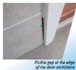
Figure 2. 20 : Defects on door
