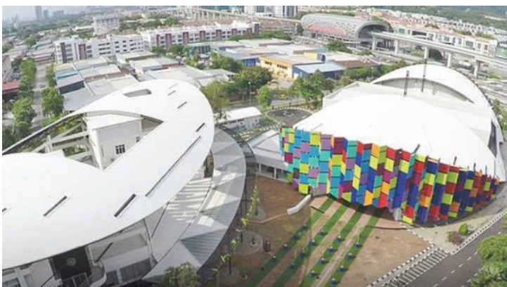
Hab e-sukan dalam pembangunan di Spacerubix, Puchong, Selangor.
