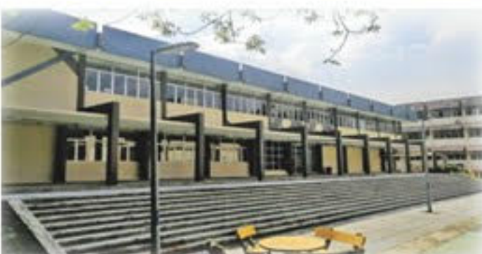
Bangunan Jabatan Arkib Universiti, PTAR di Kompleks Kenanga, UiTM Shah Alam
