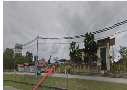
Photo 3.4.2.2: Kolej Komuniti Rompin
